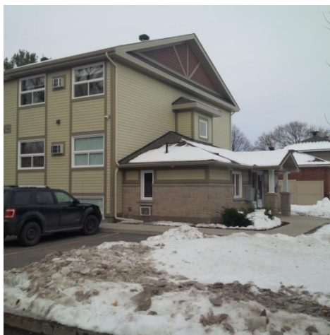
Immeuble d'appartements de trois étages de Société John Howard d'Ottawa : 22 unités d'une chambre et une unité entièrement accessible.
