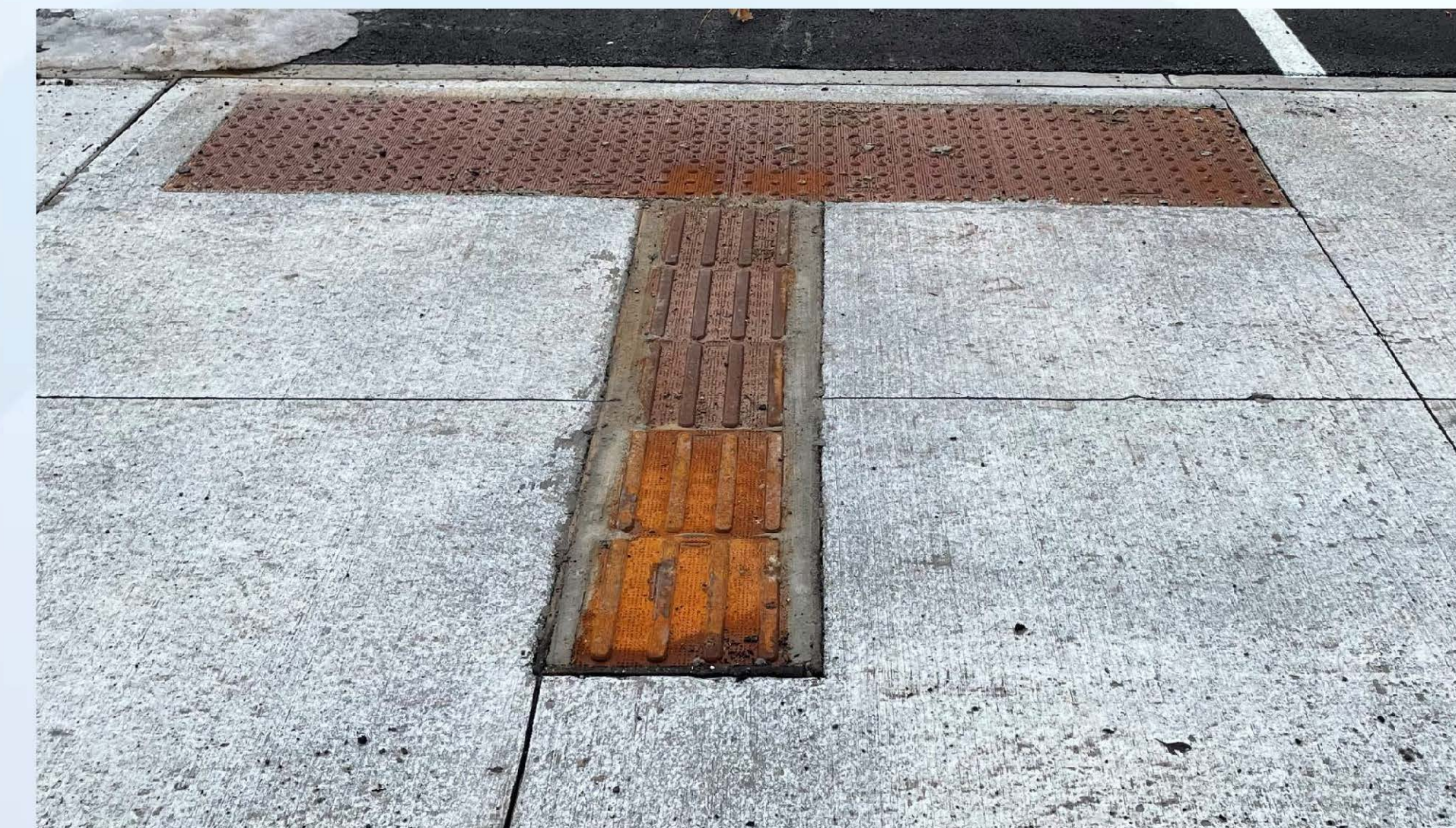
Tactile Walking Surface Indicators (TWSI's) and Directional TWSI Indicateurs tactiles de surface de marche (ITSM) et ITSM directionnels
