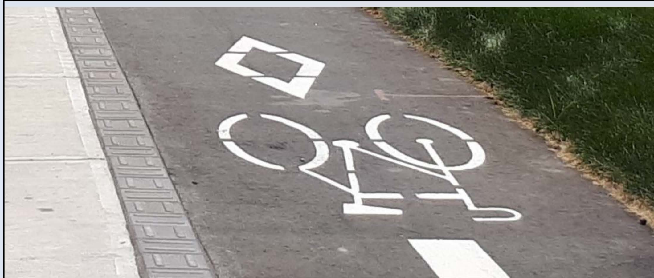
Delineator tiles between sidewalk and cycle track Dalles de délimitation entre le trottoir et la piste cyclable
