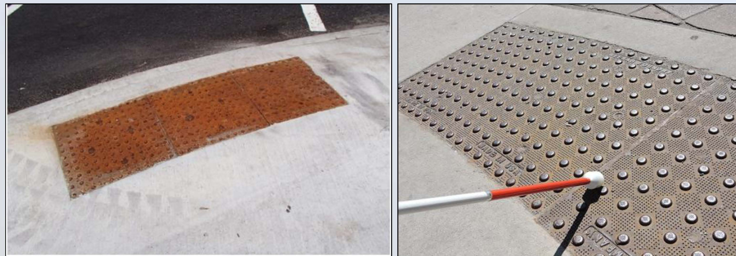
Tactile Walking Surface Indicators (TWSI's) only Indicateurs tactiles de surface de marche (TWSI) uniquement
