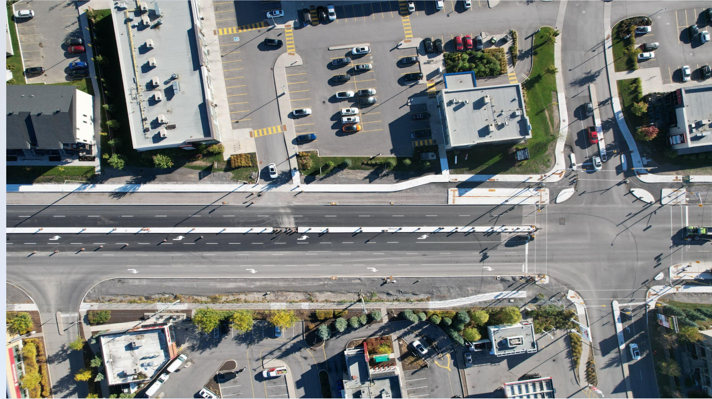
Bank Street & Shuttleworth Drive intersection and Bank Street north of the intersection, October 2025 Intersection de la rue Bank et de la promenade Shuttleworth, et rue Bank au nord de l'intersection, octobre 2025
