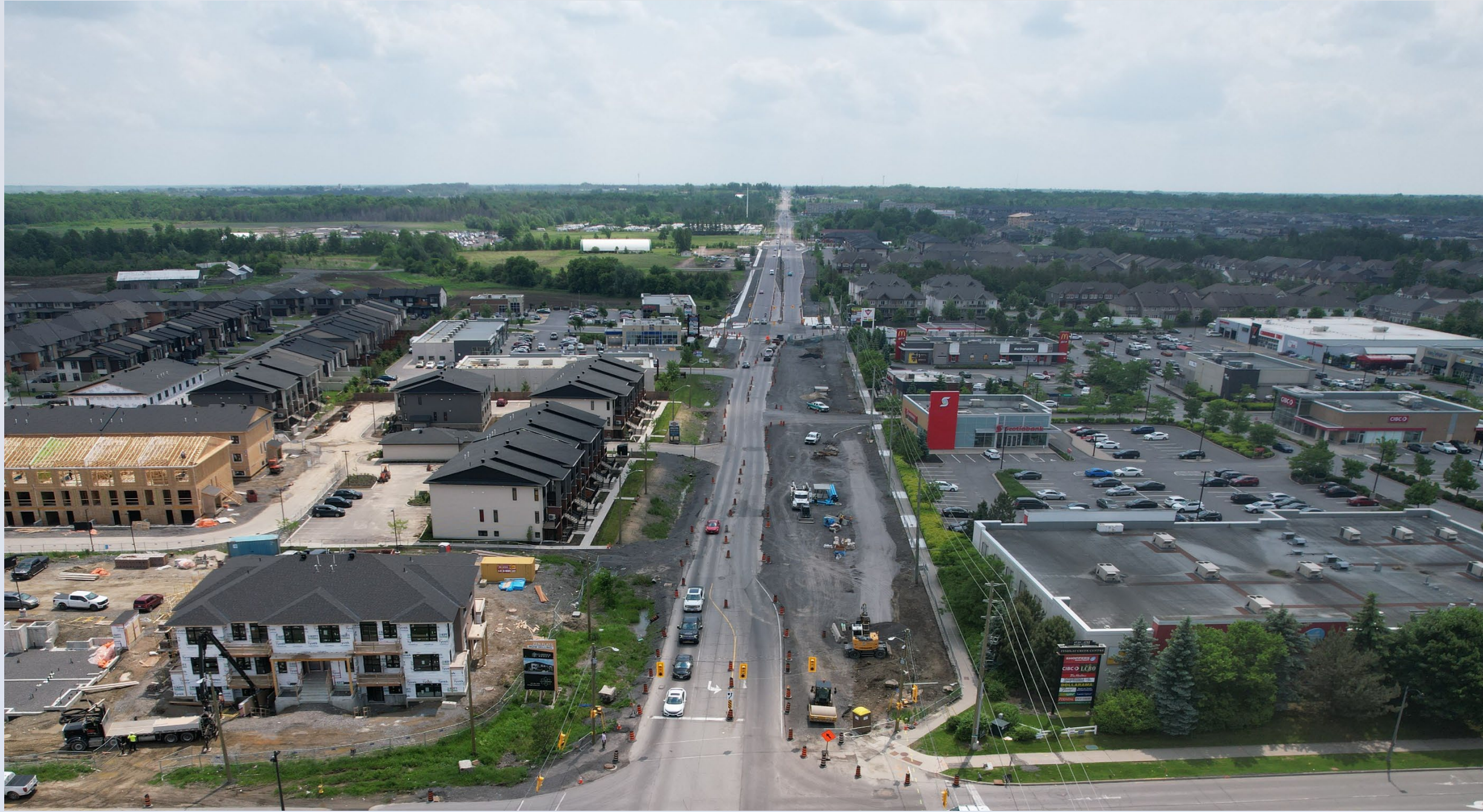
Bank Street from Findlay Creek Drive (facing south) – Road under construction, June 2025 Vue de la rue Bank depuis la promenade Findlay Creek (en direction sud) – chaussée en construction, juin 2025
