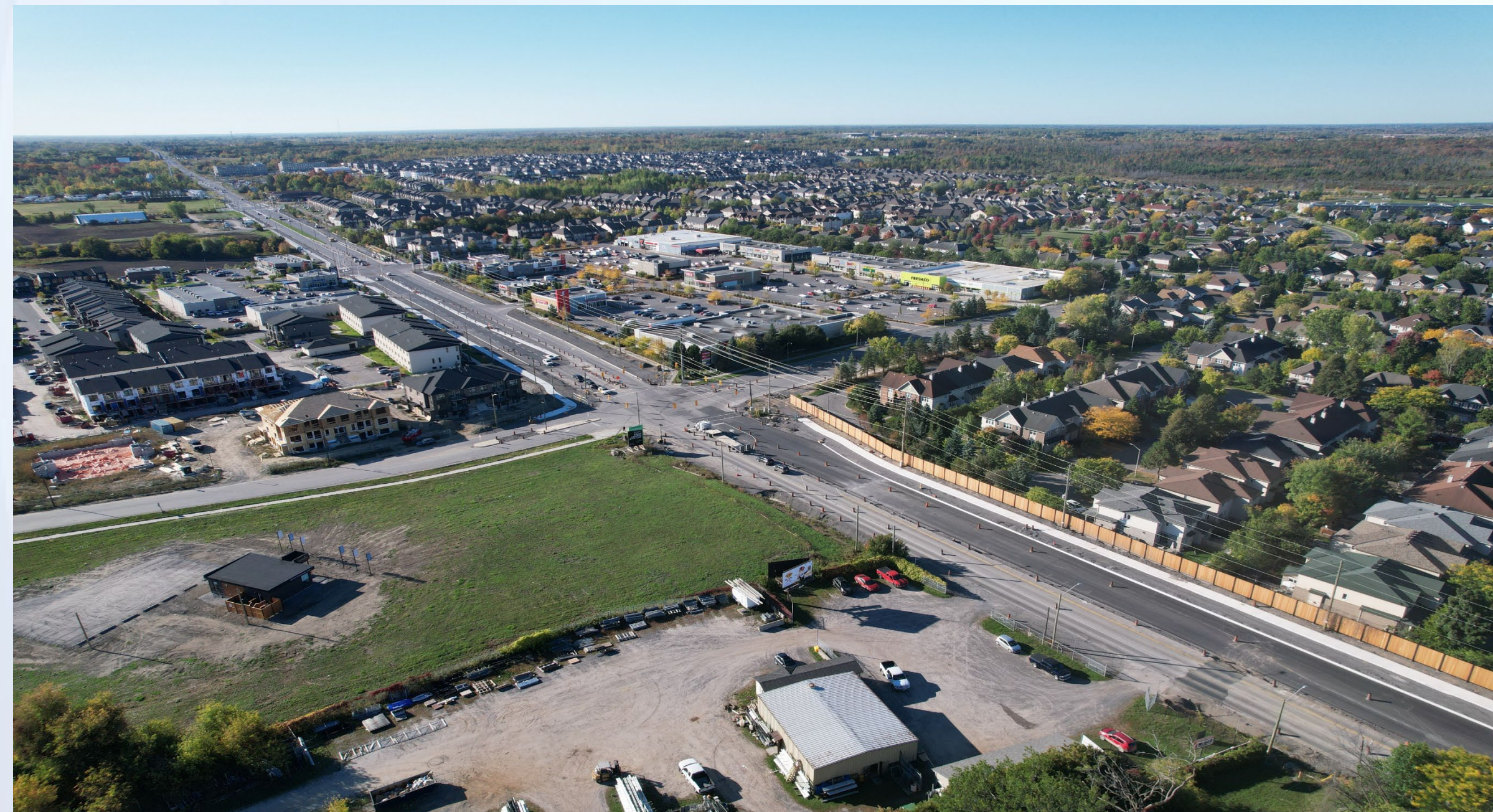
Bank Street north of Findlay Creek Drive – west side widened, new sidewalk and noise barrier October 2025 Rue Bank au nord de la promenade Findlay Creek — côté ouest élargi; nouveau trottoir et écran antibruit, octobre 2025
