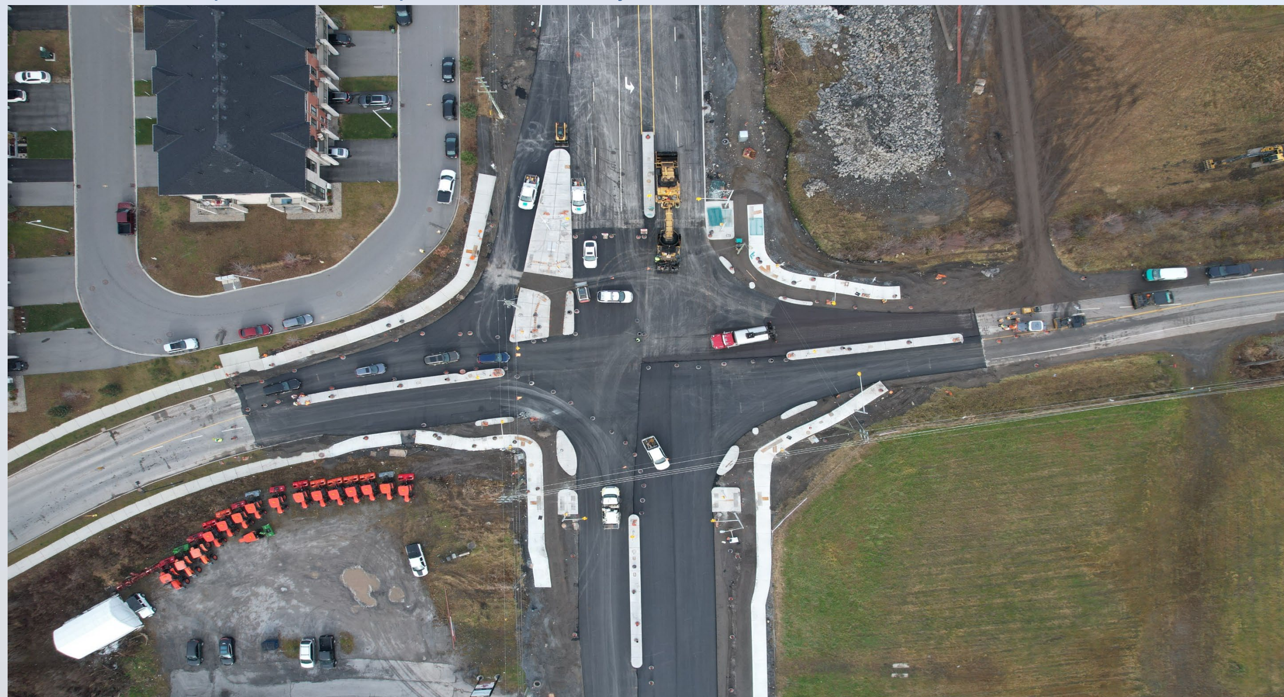
Bank and Blais/Miikana intersection Intersection de la rue Bank et des chemins Blais et Miikana
