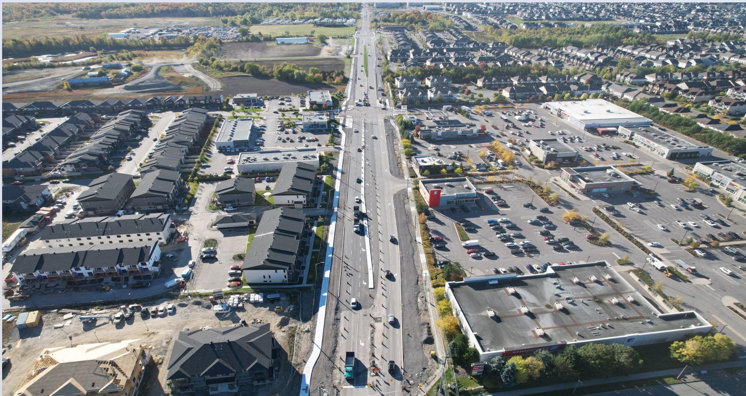
Bank Street from Findlay Creek Drive (facing south) – Road widened, October 2025 Vue de la rue Bank depuis la promenade Findlay Creek (en direction sud) – chaussée élargie, octobre 2025
