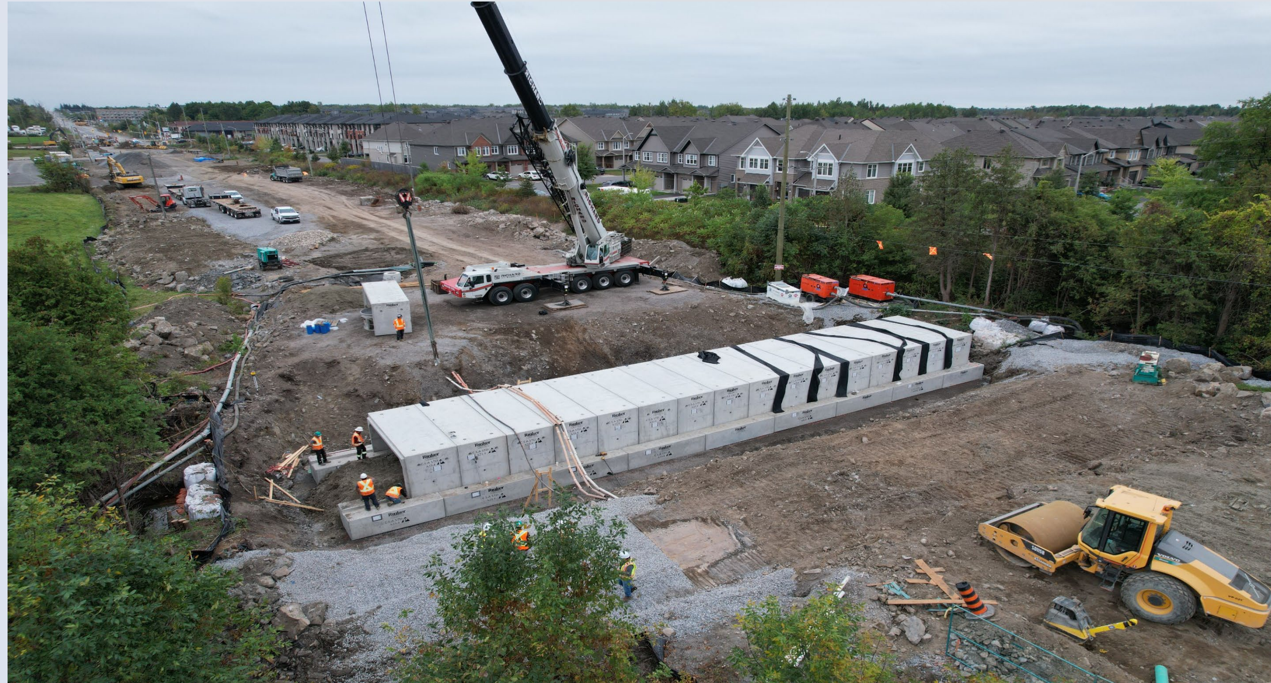
Findlay Creek Culvert installation Installation d'un ponceau sur la promenade Findlay Creek
