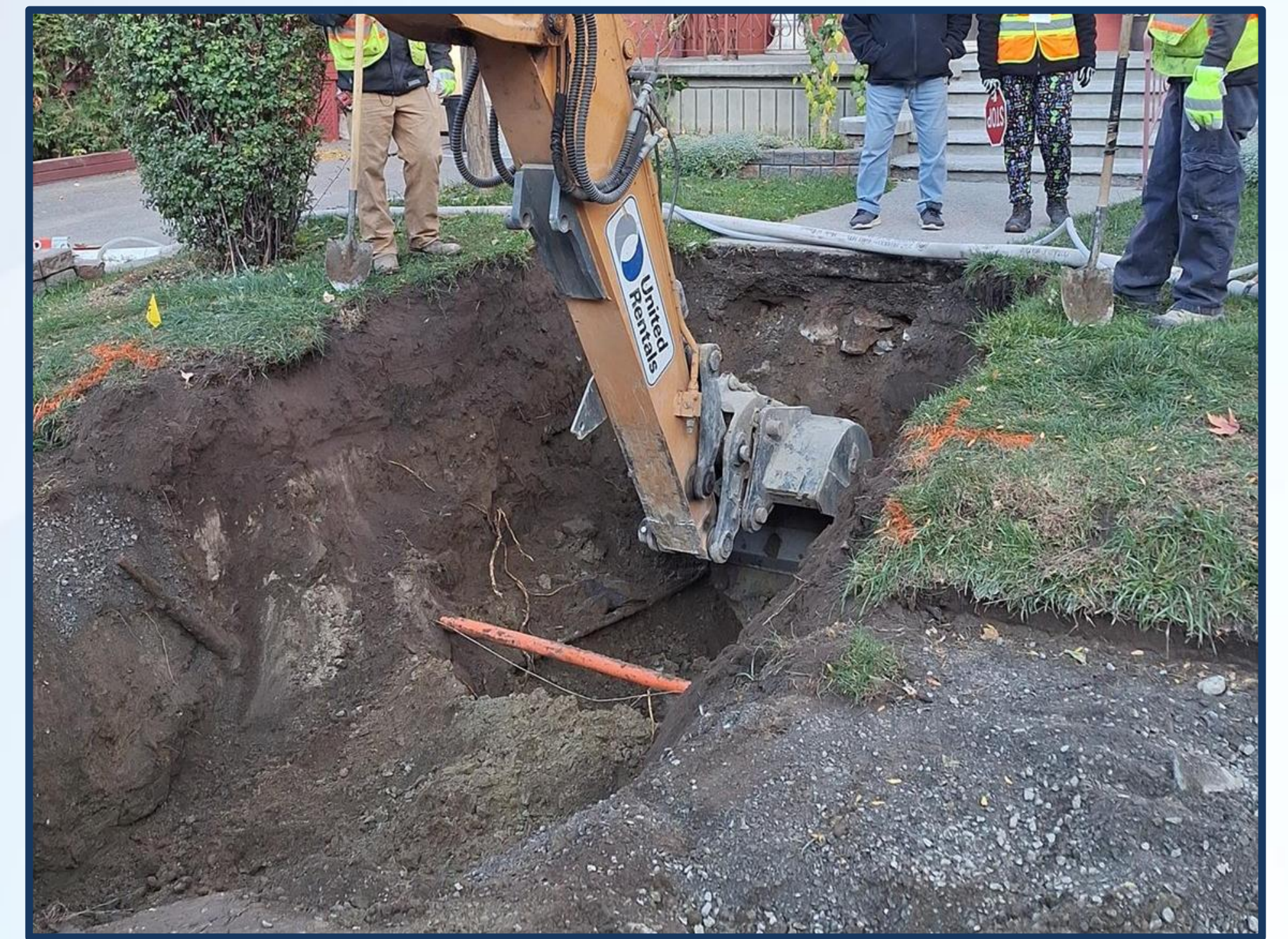
Service d'excavation jusqu'aux lignes de propriété
