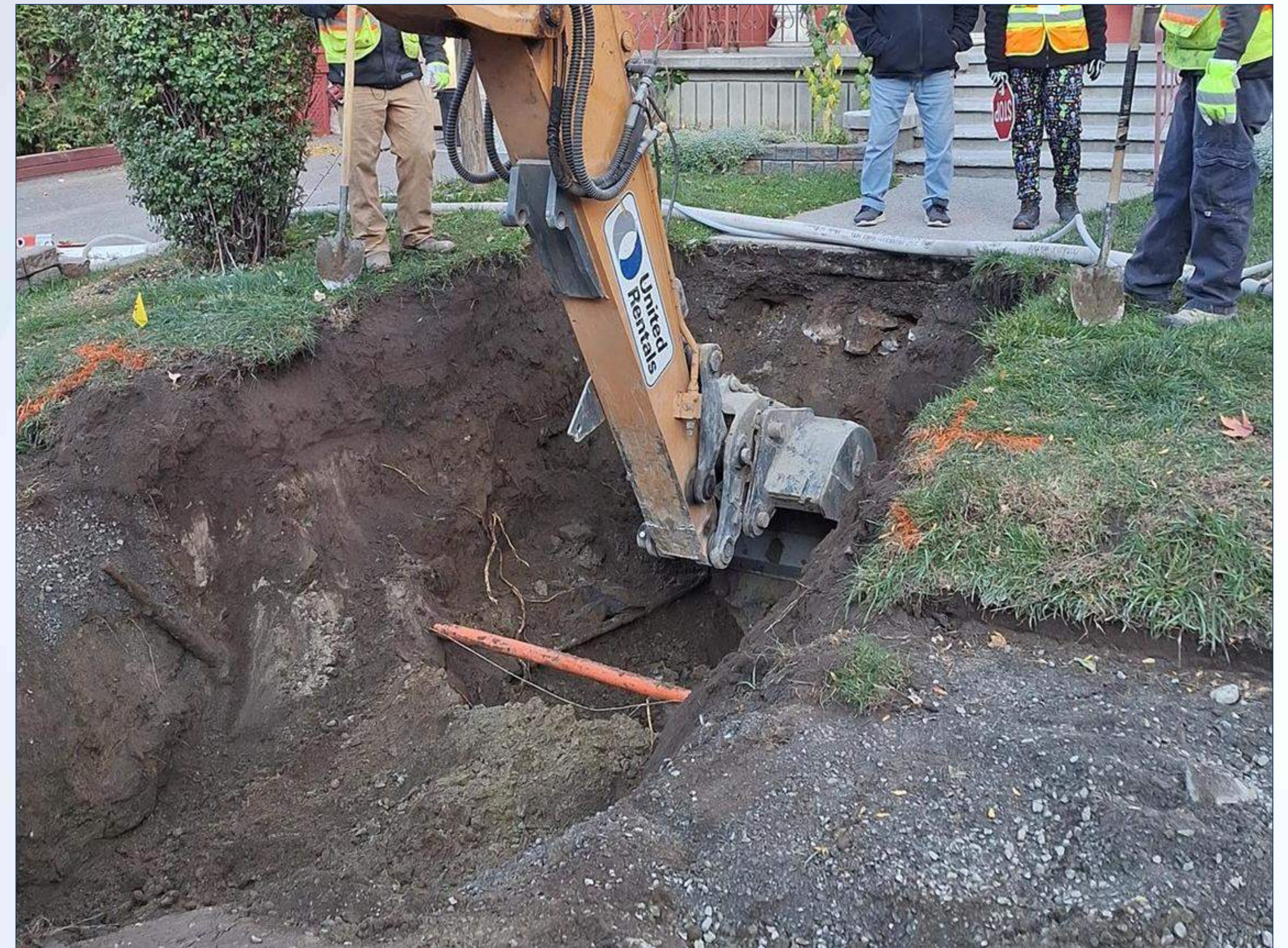
Excavation des conduites de raccordement jusqu'à la limite des propriétés
