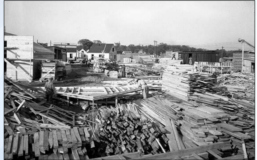
Logements pour anciens combattants en construction sur l'avenue Carling, 1945 (Archives de la Ville d'Ottawa/CA024989)
