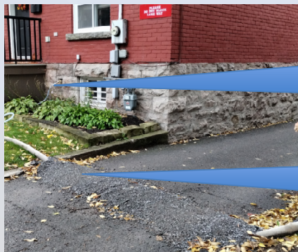
Tuyau temporaire enfoui sous le gravier de l'entrée de cour
