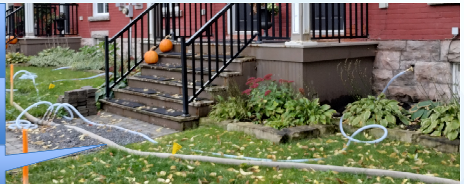
Tuyau temporaire enfoui sous le gravier de l'entrée de cour
