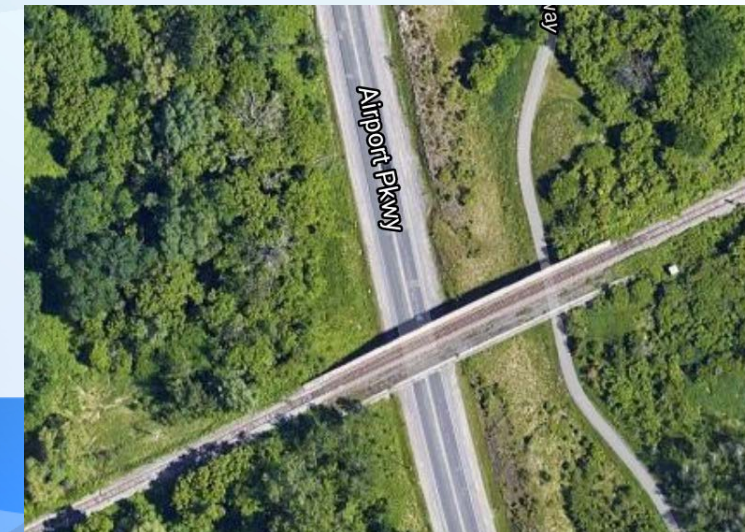
Pont ferroviaire du CN enjambant la promenade de l'Aéroport
