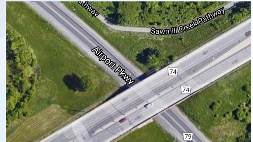
Pont du chemin Walkley enjambant la promenade de l'Aéroport
