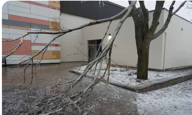
Image 17 : Arbres endommagés à cause du vent et du verglas
