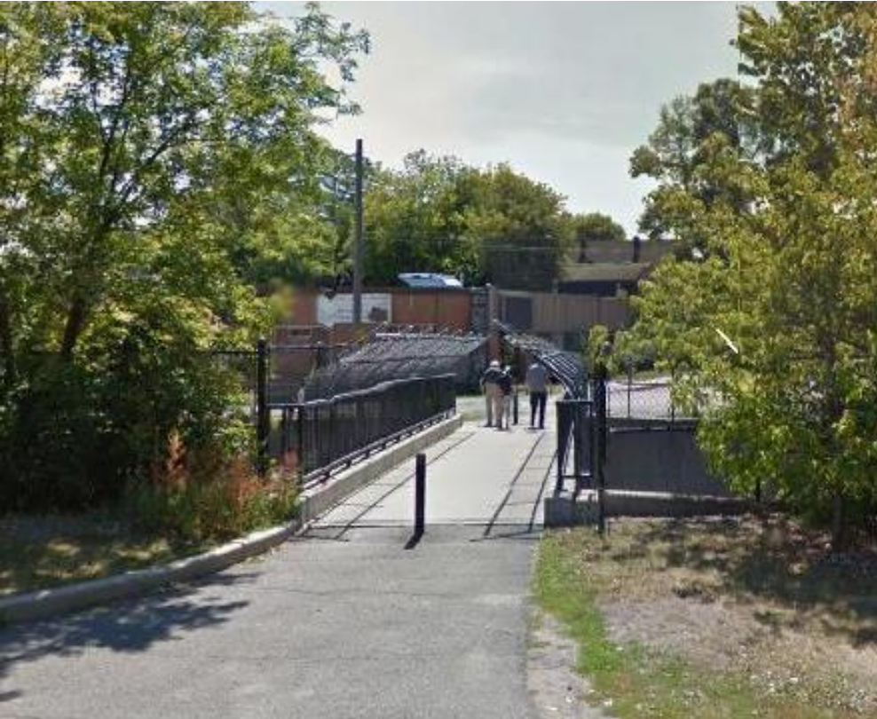
Passerelle pour piétons actuelle (vue en direction sud depuis l'avenue Workman)
