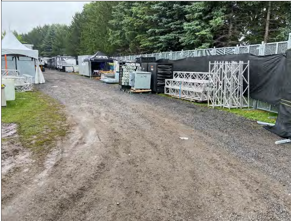
Photo 20 : Rigole de drainage du périmètre est : On a observé certaines zones de sols dénudés et des ornières creusées par les pneus non loin du secteur dont la surface granulaire a été refaite. Ces zones servent aussi à remiser le matériel et l'équipement.
