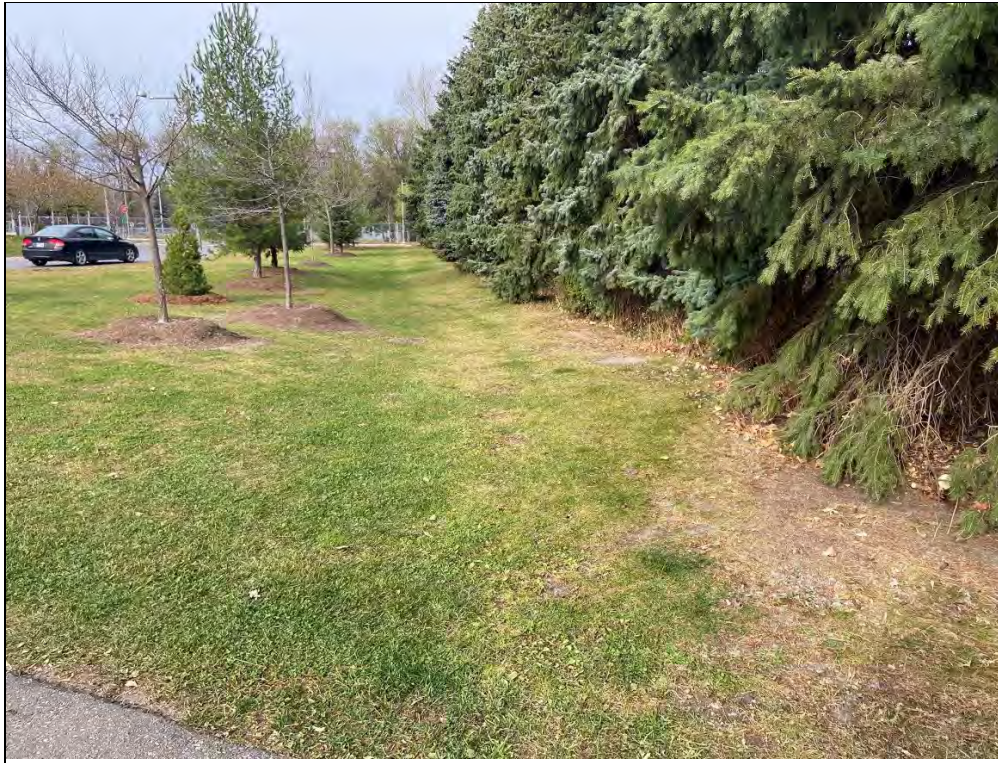
Photo 21 : Rigole de drainage du périmètre est : Panorama général de la rigole à l'est de la patinoire et du verger patrimonial. On a observé des zones réduites de sols dénudés dans le secteur de la tranchée des services publics qui avait été creusée dans la rigole.
