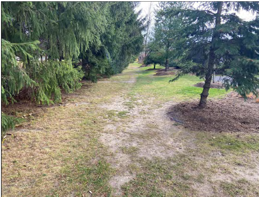
Photo 22 : Rigole de drainage du périmètre est : Panorama général de la rigole à l'est de l'aire de jeux pour les enfants. On a observé certaines zones de sols dénudés le long du périmètre de la propriété.
