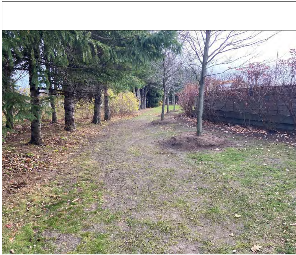
Photo 20 : Rigole de drainage du périmètre est : Zones de sols dénudés et végétation stressée à l'est de l'esplanade de jets d'eau
