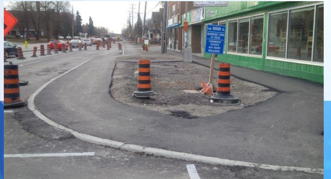
Exemple d'un parcours sûr et accessible permettant aux piétons de traverser le chantier.
