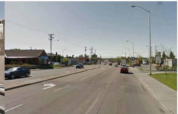
CONDITIONS ACTUELLES DE LA RUE BANK À L'INTERSECTION DU CHEMIN WALKLEY
