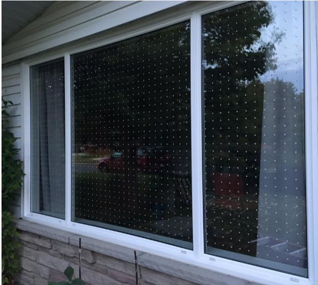
Figure 11 : Exemples d'habillage de fenêtre [marqueur visuel (murale) réalisé avec de la peinture à l'huile en haut à gauche, ruban adhésif Feather Friendly DIY en bas à gauche et Acopian BirdSaver (cordes de parachute) à droite]. Photos gracieusement offertes par Kate Stolwyk, Karen Gordon et Safe Wings Ottawa.
