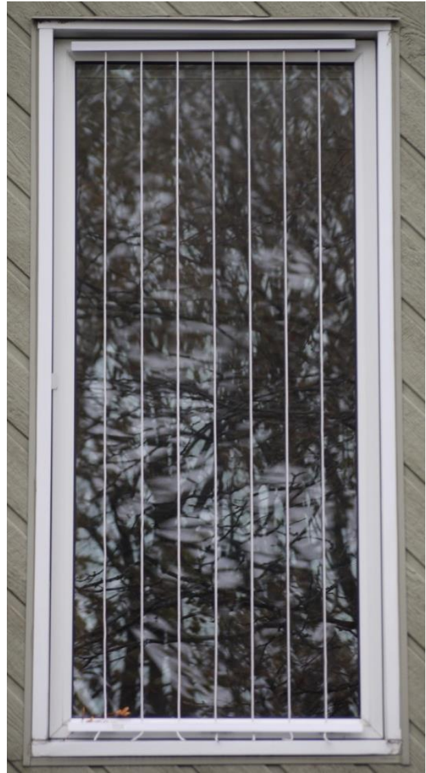
Figure 11 : Exemples d'habillage de fenêtre [marqueur visuel (murale) réalisé avec de la peinture à l'huile en haut à gauche, ruban adhésif Feather Friendly DIY en bas à gauche et Acopian BirdSaver (cordes de parachute) à droite]. Photos gracieusement offertes par Kate Stolwyk, Karen Gordon et Safe Wings Ottawa.
