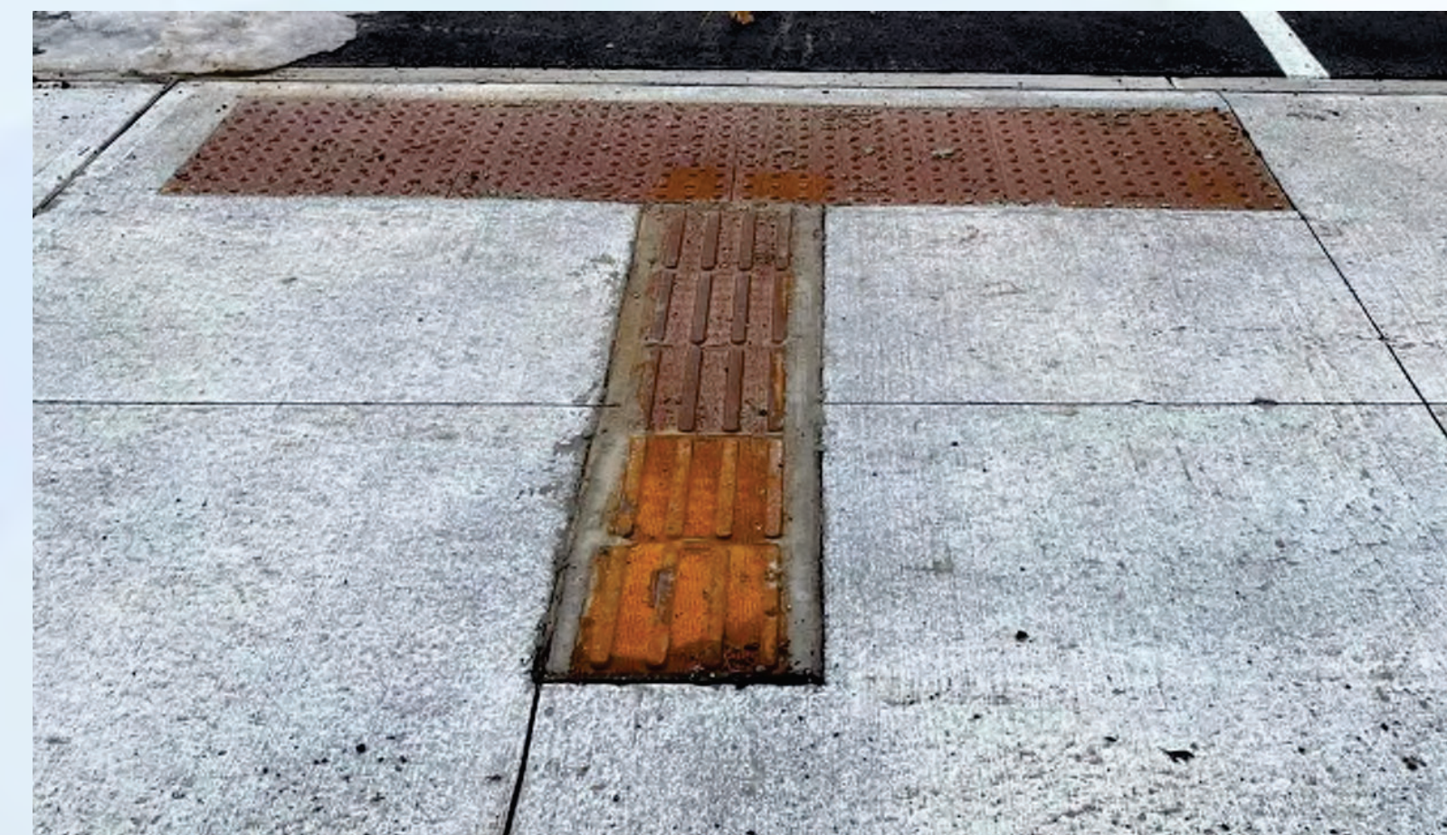
Tactile Walking Surface Indicators (TWSI's) now include Directional TWSI's where applicable Les indicateurs tactiles de surface de marche (ITSM) incluent désormais des ITSM directionnels, le cas échéant.
