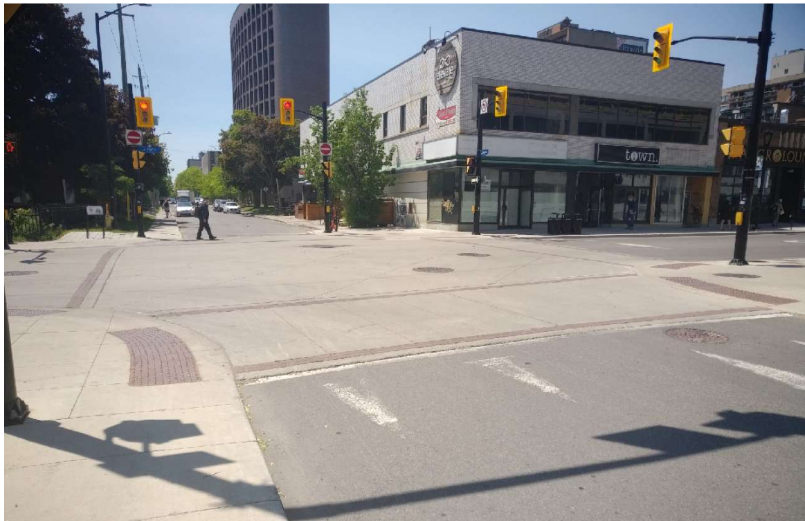
Raised crossing at Gilmour Street and Elgin Street Passage surélevé sur la rue Gilmour et la rue Elgin
