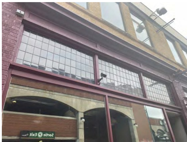
Figure 40 : Exemples de fenêtres à vitres multiples et à verre au plomb dans le DCP
