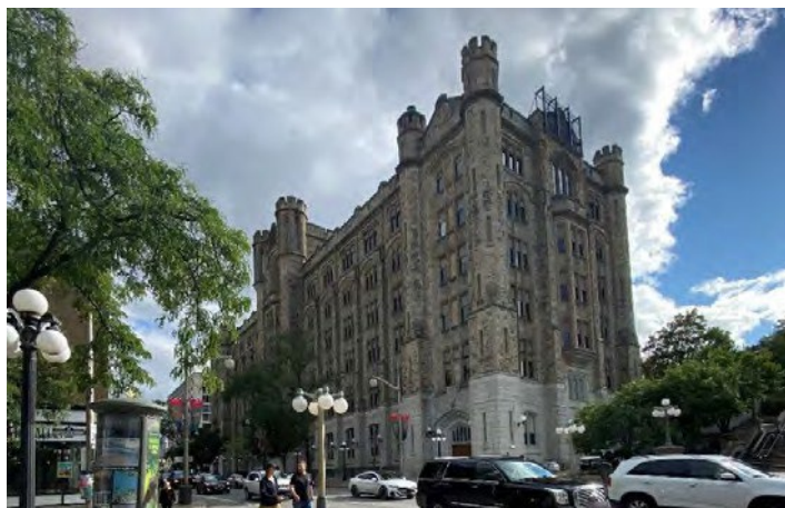
Figure 30 : Édifice Connaught au 555, avenue MacKenzie
