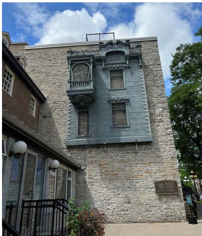
Figure 29 : Façade de la maison de fer-blanc dans la cour de cette maison
