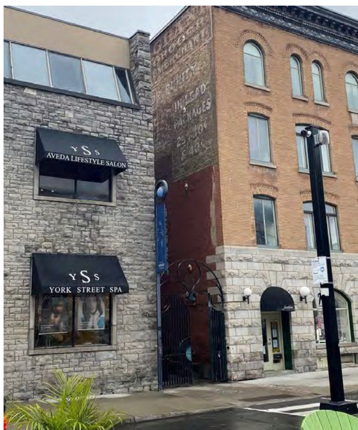
Figure 31 : Deux bâtiments donnant sur la rue York et enseignes-auvents actuelles et reliquats d'une ancienne enseigne murale peinte
