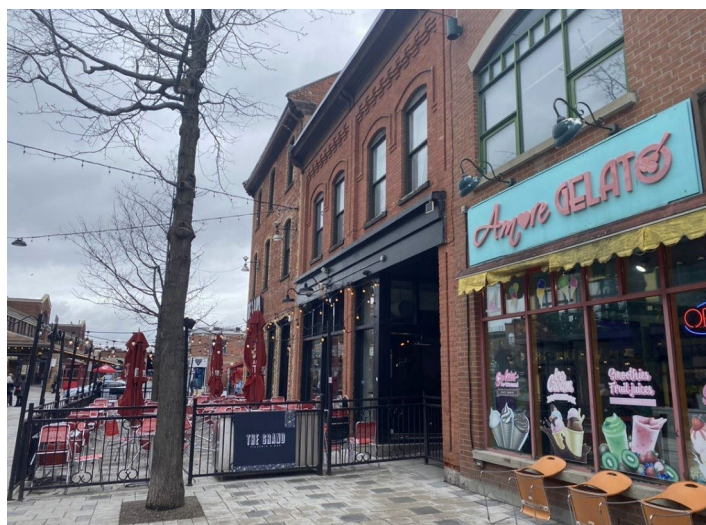
Figure 3 : Bâtiments polyvalents de la galerie marchande de la rue William
