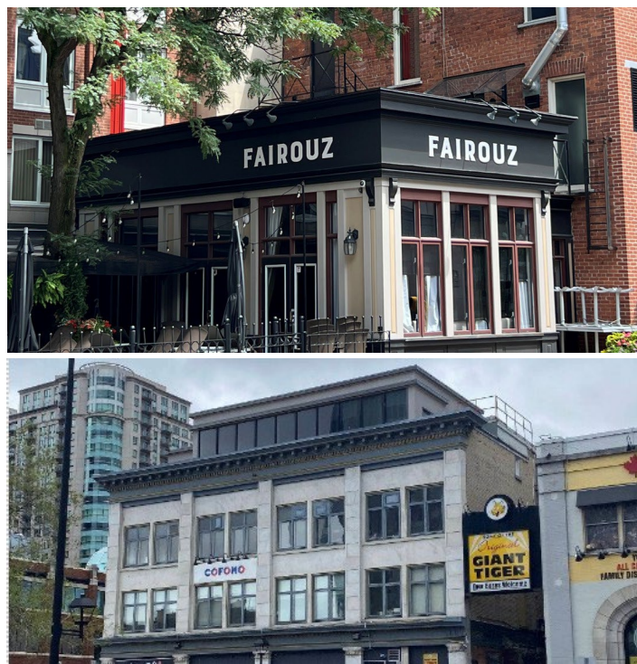
Figure 47 : Exemples d'annexes de plain-pied et construites sur les toits avec succès
