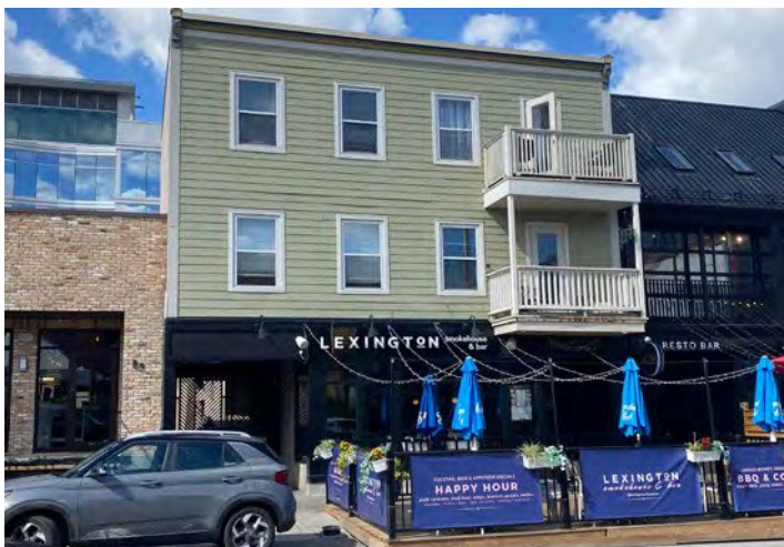
Figure 46 : Exemple d'allée cochère restante au 95, rue Clarence
