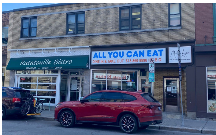
Figure 49 : Façade d'un établissement commercial donnant sur la rue Dalhousie et entrées donnant accès aux étages supérieurs à partir de la rue
