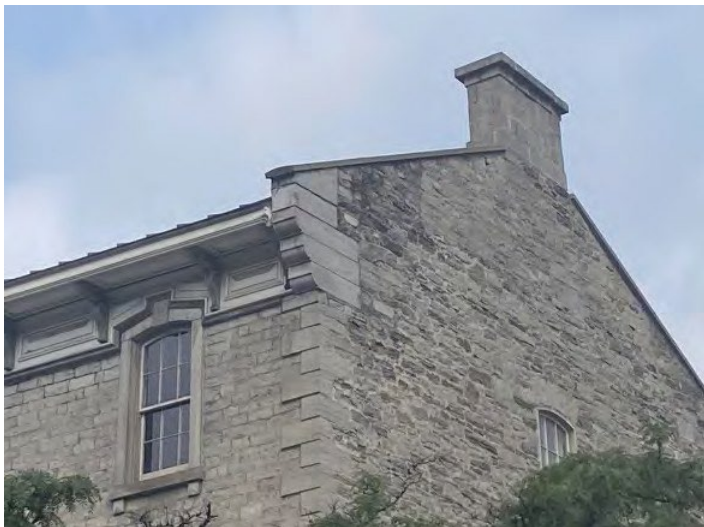
Figure 44 : Cheminée de pierre historique à l'arrière du 541, promenade Sussex, depuis la rue George
