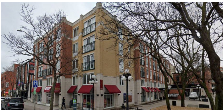
Figure 48 : Exemple de construction neuve compatible donnant sur la rue Murray
