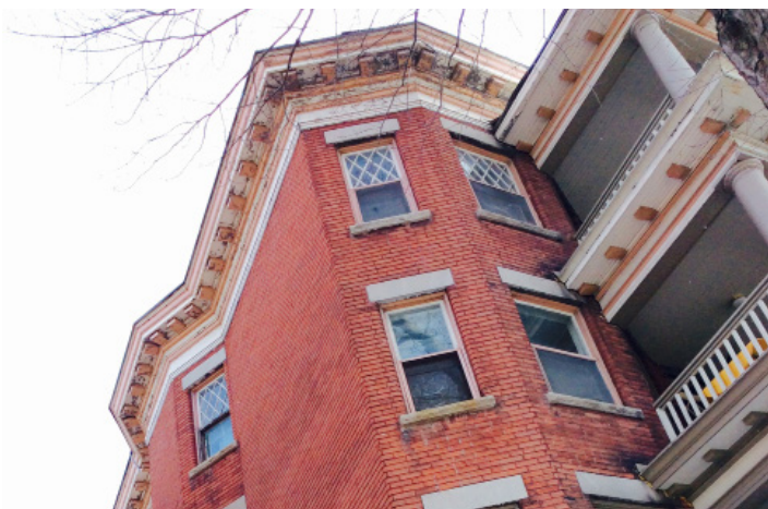
Figure 14 : Exemples de différents modèles et détails de fenêtre, comme le verre au plomb.
