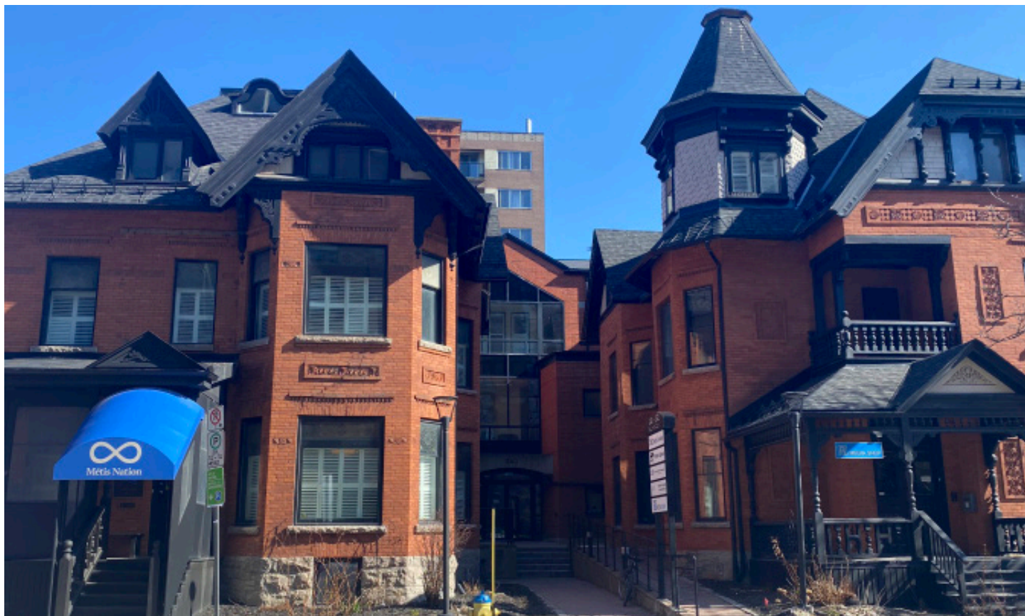
Figure 23 : Annexe pensée pour s'adapter au contexte et située à l'arrière des édifices
