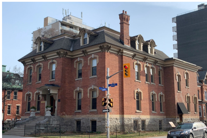
Figure 12 : Maison Campbell, parée de toutes sortes d'éléments de toiture et de lucarnes. Crédit photo : ERA Architects Inc.
