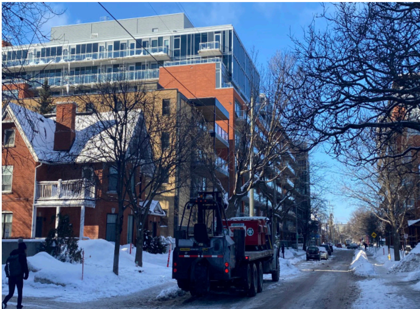
Figure 26 : Image d'une construction neuve sur la rue McLeod; les étages supérieurs sont décalés vers l'arrière, ce qui donne du relief à la volumétrie et ce qui permet d'assurer la transition avec les propriétés de moindre envergure au milieu du quadrilatère.
