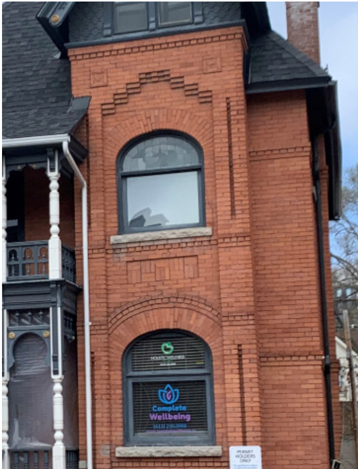
Figure 13 : Exemple de maçonnerie de brique historique dans le centre-ville, notamment au 355, rue Waverley, dont les assises de ceinture et les voussoirs ouvragés.
