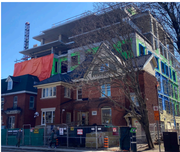
Figure 25 : Une fois achevé, ce projet intégrera deux édifices historiques contributifs dans un grand immeuble d'appartements derrière.
