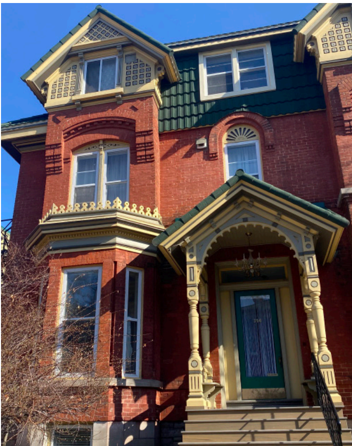
Figure 16 : Exemples d'ouvrages de menuiserie complexes dans le pignon, sur les supports, dans les encorbellements, maçonnerie de brique ouvragée et crêtes de fer forgé.
