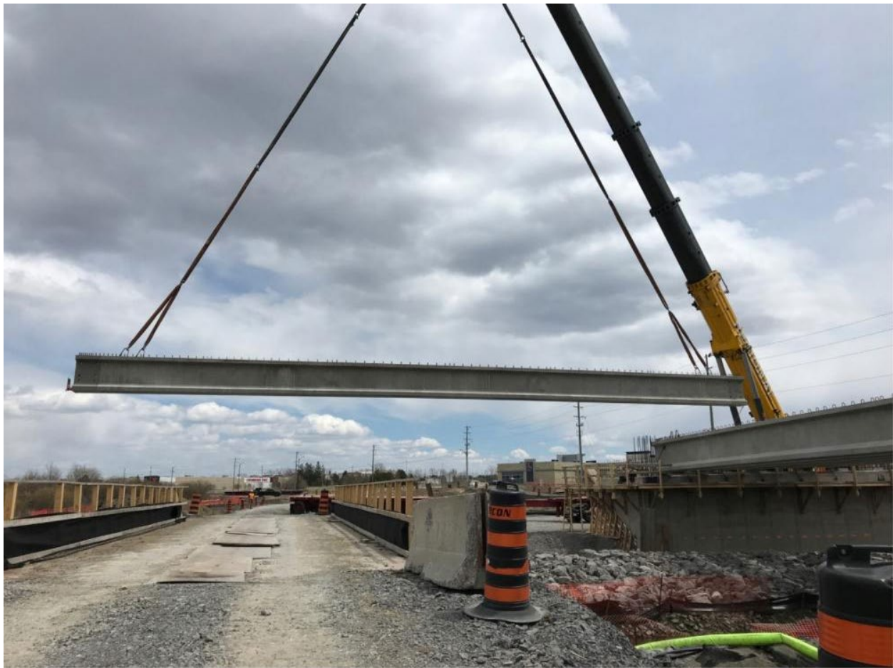
Installation des appuis du pont
