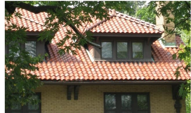
FIGURE 27 : TOIT EN TUILES D'ARGILE
