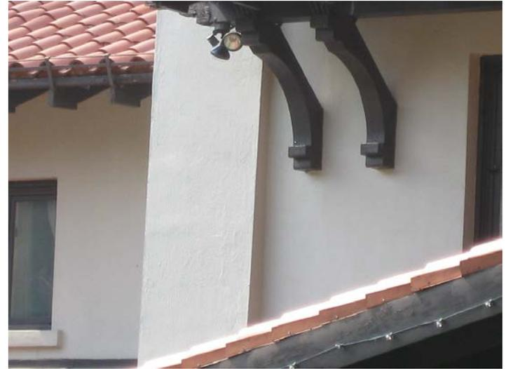
FIGURE 28 : PAREMENT EN STUC LISSE AU 85, AVENUE GLEBE
