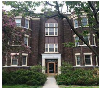
Adresse : 325, avenue Clemow Année de la construction : 1931 Builder: MacDonell & Conyers
