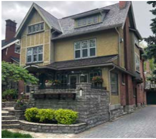
Adresse : 197, avenue Clemow Année de la construction : 1911 Architecte : John Albert Ewart
