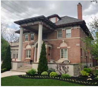
Adresse : 211, avenue Clemow Année de la construction : 1910 Architecte : Arthur Le B. Weeks
