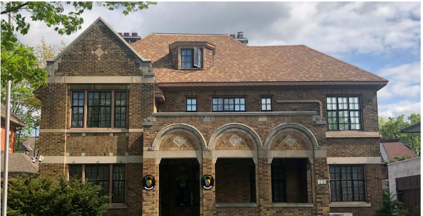
Figure 5 : Exemple de revêtement en brique avec menus ouvrages de maçonnerie décorative
