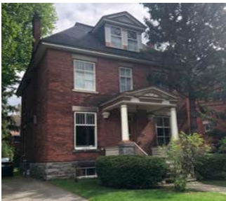
Adresse : 226, avenue Clemow Année de la construction : 1909 Architecte : Arthur Le B. Weeks
