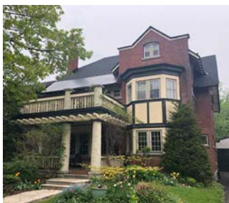
Adresse : 31, avenue Monkland Année de la construction : 1921 Architecte : Walter Herbert George
