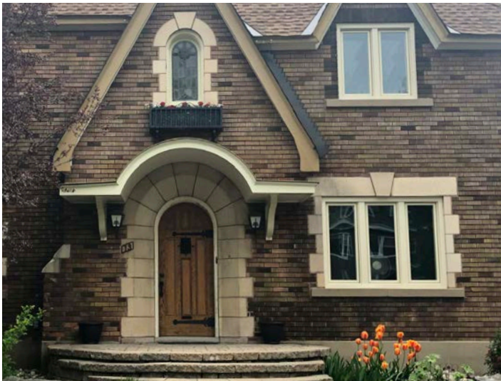
Figure 12: Exemple de pierre angulaire encadrant les fenêtres et la porte
