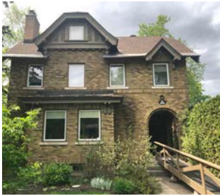
Adresse : 263, avenue Clemow Année de la construction : 1916 Architecte : John Albert Ewart
