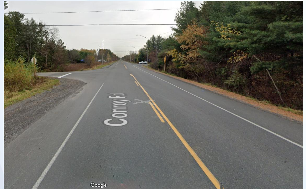
Tronçon nord du chemin Conroy en direction sud
