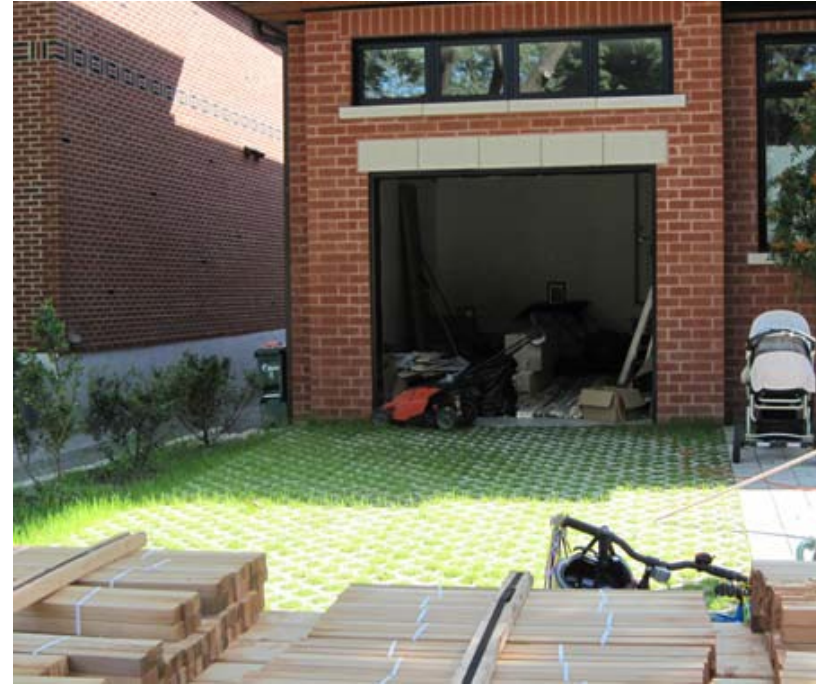
Figure 29 : Les blocs alvéolés gazonnés constituent un socle stable pour le stationnement, en augmentant l'infiltration des eaux de surface sur le site.
