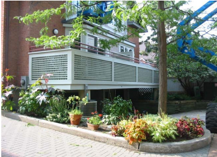
Figures 12 et 13 : Dans ces deux rangées de maisons intercalaires, qui cernent une cour de stationnement interne, on a fait appel à un vaste paysagement pour rehausser le projet d'aménagement. Les généreux balcons font oublier les garages en retrait.
