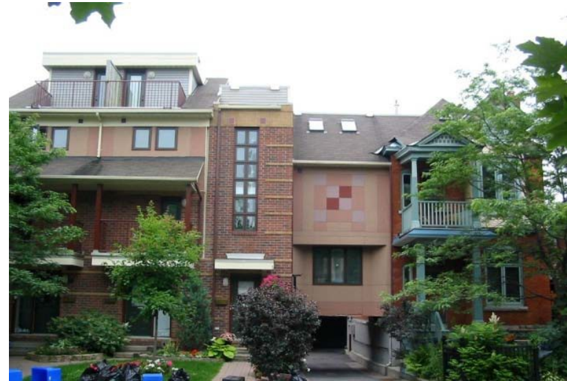
Figure 27 : La conception de cet aménagement intercalaire minimise l'incidence du rangement des voitures en implantant les places de stationnement communes derrière l'immeuble, pour qu'elles fassent partie du site et qu'elles soient accessibles grâce à une voie d'accès abaissée.
