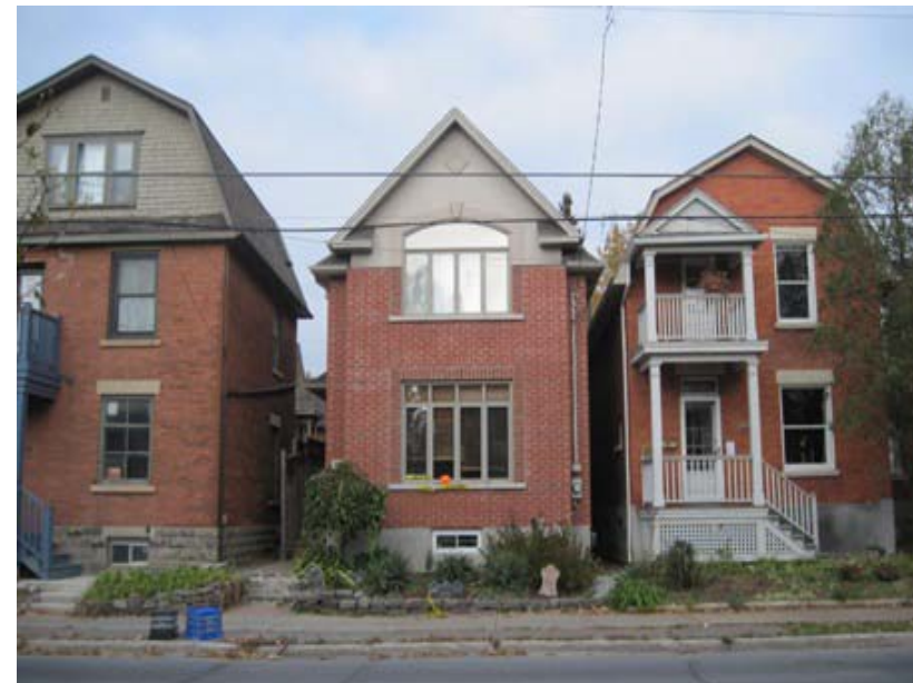
Figure 16 : La hauteur, la largeur, les matériaux et le traitement paysager de cet aménagement intercalaire reprennent ceux des habitations existantes de chaque côté.
