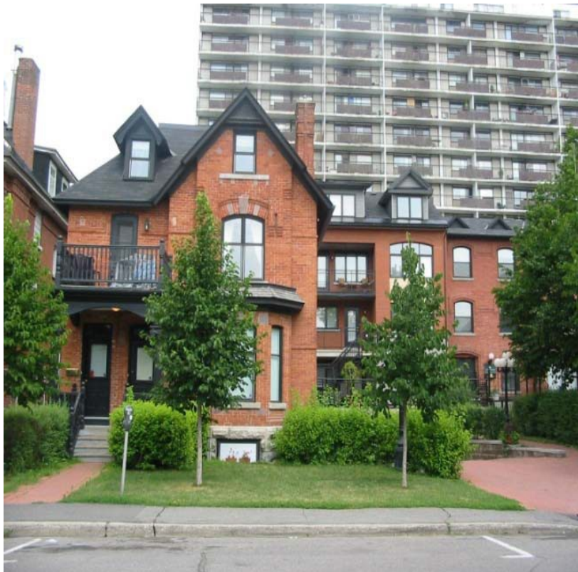
Figure 30 : L'annexe intercalaire de brique rouge, qui est décalée vers l'arrière à la droite de ce bâtiment de quartier, se marie au contexte existant grâce à sa composition, à ses matériaux et à ses coloris compatibles. Son implantation sur le site met en vitrine l'édifice patrimonial.
