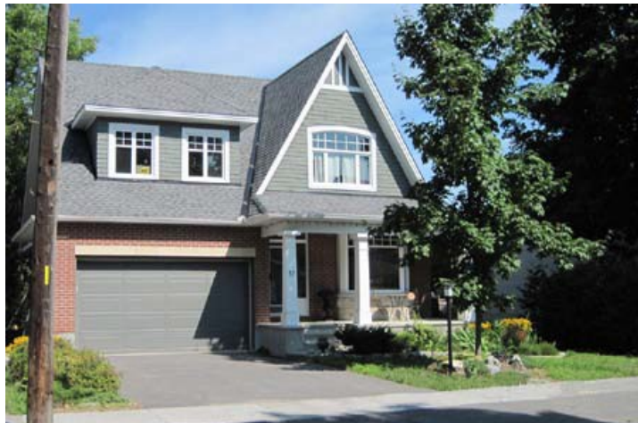
Figures 22 et 23 : Les portes et les fenêtres de la façade avant, proches du sol, créent une lisière attrayante pour le trottoir public. Abaisser l'élévation du rez-de-chaussée permet de réduire les besoins pour ce qui est des marches en saillie, ce qui permet d'aménager une surface végétalisée maximale dans la cour avant.
