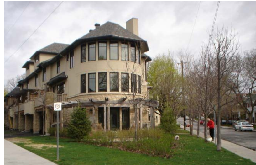
Figure 17 : La façade courbe, reprise par la tonnelle courbe, crée un traitement d'angle exceptionnel qui rend plus attrayant le domaine public. Le vitrage important concourt à la surveillance communautaire.
