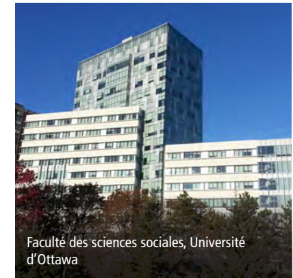
Faculté des sciences sociales, Université d'Ottawa Figure 2-20 : Exemple de l'intégration de la salle mécanique sur le toit dans l'expression de l'esthétique architecturale dans son ensemble.
