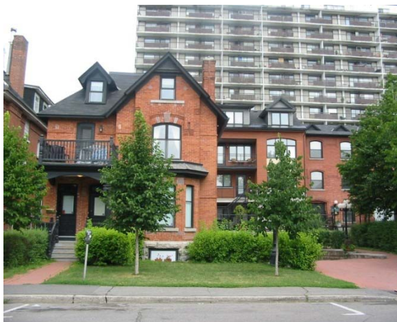
Figure 34 : Le rajout intercalaire en brique rouge, aménagé en retrait à la droite de ce bâtiment de quartier, s'insère harmonieusement dans le contexte existant grâce à une composition, à des matériaux et à des coloris compatibles. Son emplacement met le bâtiment patrimonial en valeur.
