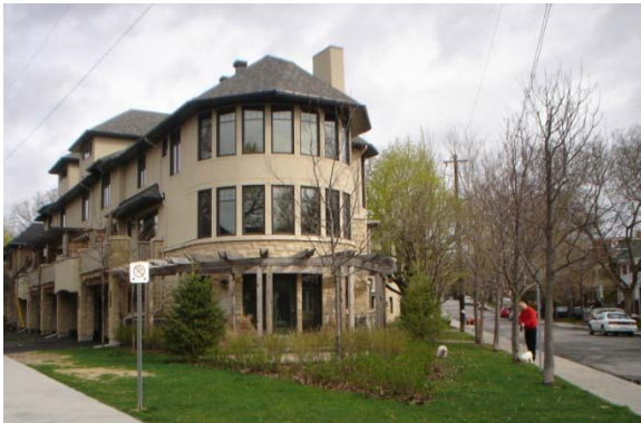
Figure 19 : La façade courbée, qu'épouse la tonnelle courbée, donne un aspect unique à ce bâtiment situé à une intersection et enrichit le domaine public. En outre, l'important vitrage contribue à la surveillance communautaire.
