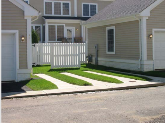
Figure 32 : Des bandes parallèles pavées entre lesquelles pousse du gazon offrent un support stable aux véhicules. Une entrée de cour en gravier permet une infiltration accrue des eaux pluviales.
