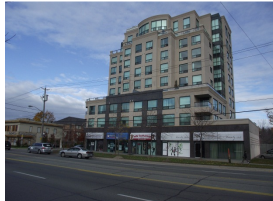
immeuble polyvalent de huit étages abritant des commerces de détail au rez-de-chaussée et des habitations aux étages supérieurs (MMM Group, 2010)
