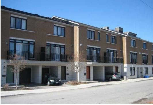
Aménagement de maisons en rangée à Ottawa (MMM Group, 2011)
