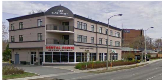
Immeuble polyvalent du secteur visé par le PCC (MMM Group, 2010)
