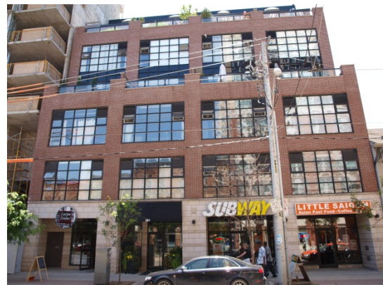
Animation en rez-de-chaussée et retrait du 3 e étage (MMM Group, 2009)
