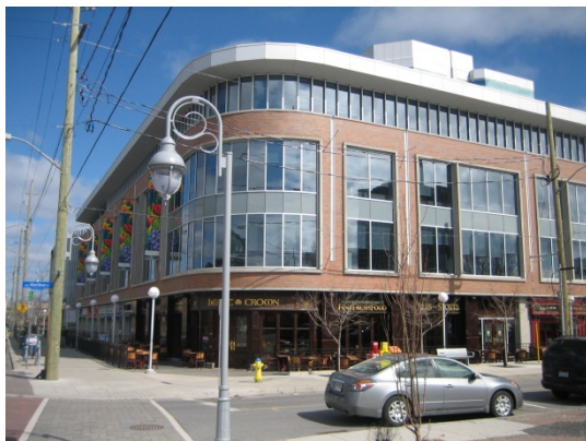
Immeuble polyvalent avec commerces de détail en rez-de-chaussée (MMM Group, 2011)
