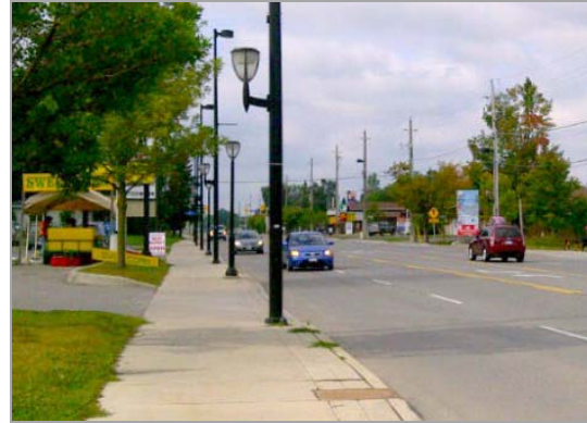
Éclairage du trottoir et de la chaussée sur la rue Perth à Richmond, Ontario (MMM Group, 2011)
