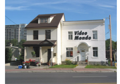
Video Mondo Building Bâtiment abritant le commerce Video Mondo
