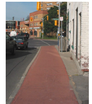
Sidewalk near Springfield Trottoir près du chemin Springfield
