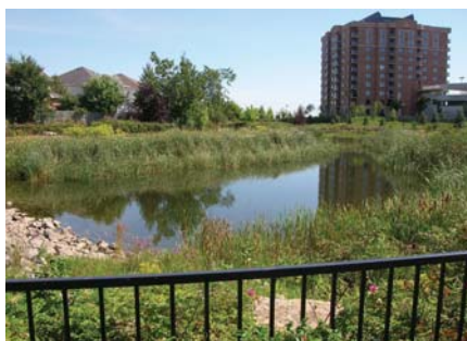
BASSIN ÉCOLOGIQUE DE RÉTENTION DES EAUX PLUVIALES
