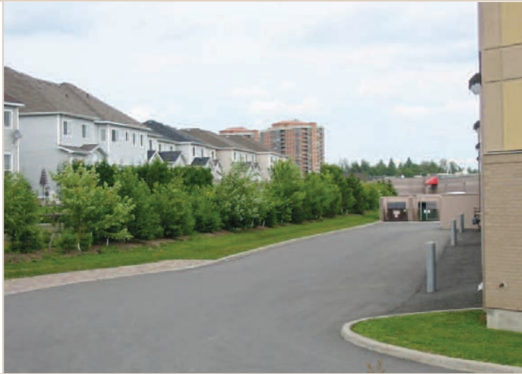
Figure 22 : Les zones tampons paysagères constituent une transition adéquate entre les magasins-entrepôts et les secteurs résidentiels.
