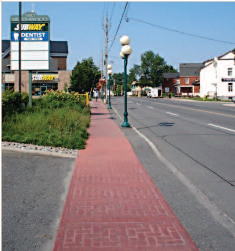
Figure 9 : L'absence de dénivellation et de points de conflit avec les véhicules crée un environnement piétonnier agréable.
