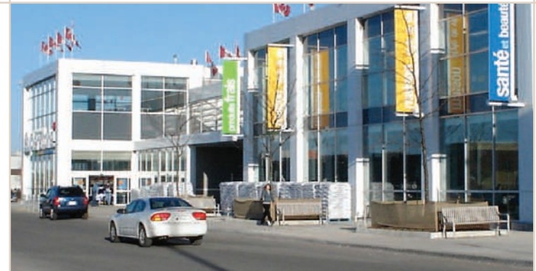
Figure 3 : Le rez-de-chaussée et le deuxième étage de cet édifice sont pourvus de fenêtres claires.
