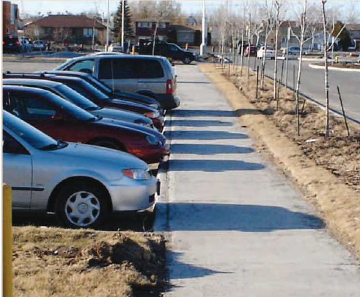
Figure 11 : Cette allée permet des déplacements à pied sans obstacles entre l'entrée du magasin et la voie publique.
