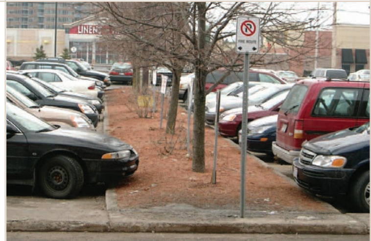
Figures 21 b : Les îlots paysagers dans les parcs de stationnement aident à réduire la superficie asphaltée sur les lieux.
