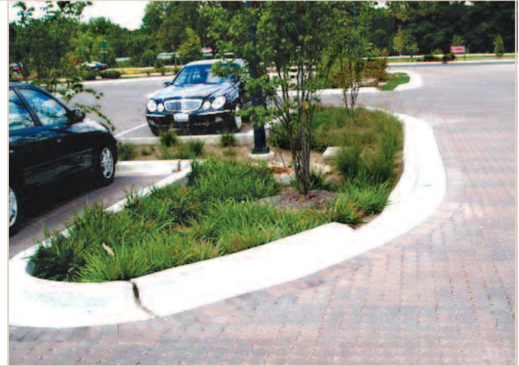
Figure 25 : Les îlots de plantation pourvus de bordures abaissées permettent de récupérer l'eau pluviale évacuée des aires asphaltées.
