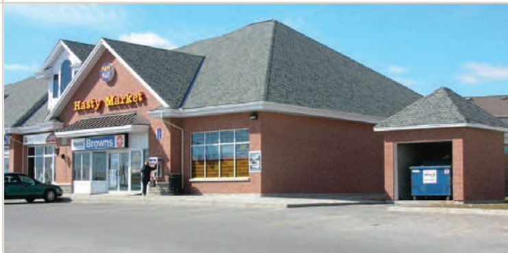
Figure 29 : Les matériaux et la conception du bâtiment de services sont harmonisés avec l'édifice principal.
