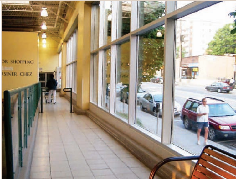
Figure 4 : La façade principale de cet édifice commercial fait face à une voie publique et présente plus de 60 % de transparence.
