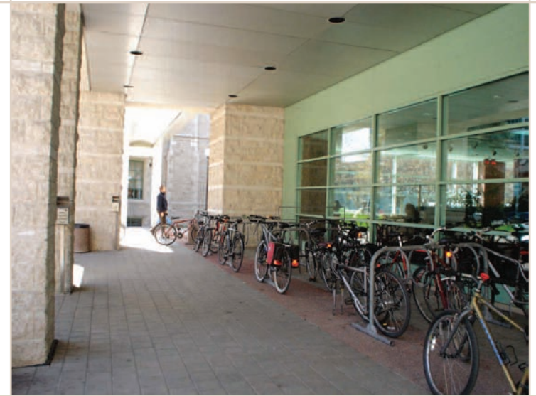
Figure 15 : Un parc de stationnement pour vélos abrité est intégré dans la conception de cet édifice.
