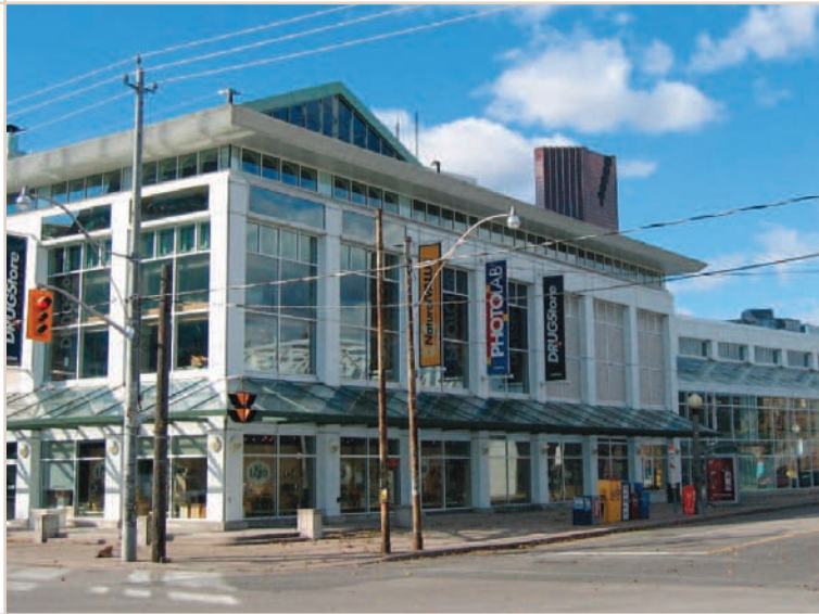
Figure 14 : Les marquises en verre de cet édifice protègent les piétons des intempéries.
