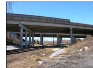
Rail crossing / passages à niveau
