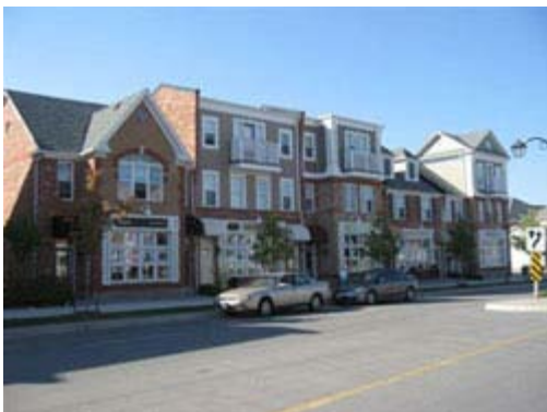
Rues résidentielles locales : paisibles, privées, bordées de porches et dépourvues de voies d'accès et de portes de garage. Des trottoirs longent la rue de part et d'autre. Avec l'aimable autorisation de Mattamy Homes
