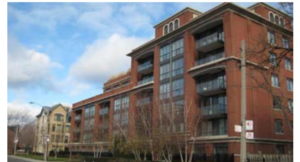
IMMEUBLE D'HABITATION DE HAUTEUR MOYENNE
