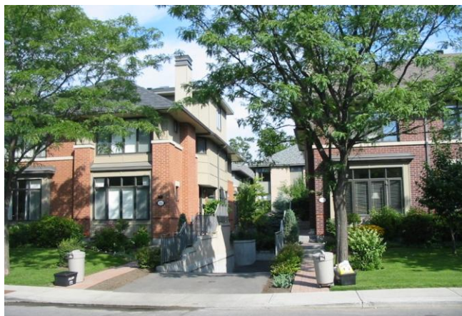
Figure 20 : Entrée donnant accès à un terrain de stationnement collectif. Aucun garage ne donne sur la rue.
