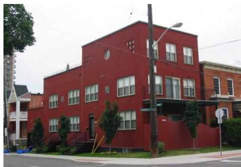
Figure 42 : Les nombreuses fenêtres sur les façades donnant sur les deux rues contribuent à réduire l'effet massif de cet immeuble résidentiel.
