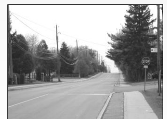
Les routes collectrices, comme le chemin Parkway, sont essentielles pour relier les quartiers de Greely.
