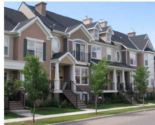
Figure 35b : Une approche similaire dans les choix d'éléments architecturaux, notamment dans la forme et la dimension des fenêtres, le traitement des galeries et des lignes de toit, peut apporter un intérêt visuel et permet la coexistence de différents types d'habitations.
