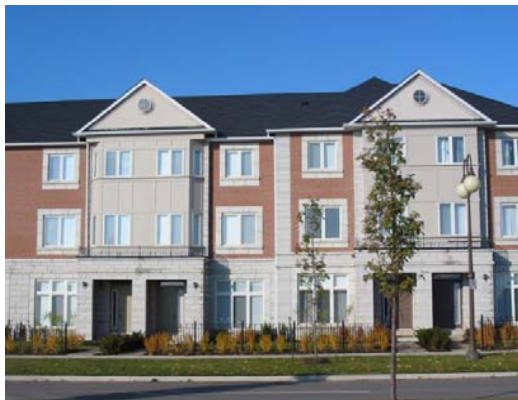
Figure 40b : Le traitement en rez-de-chaussée des portes et des fenêtres renforce l'environnement piétonnier.
