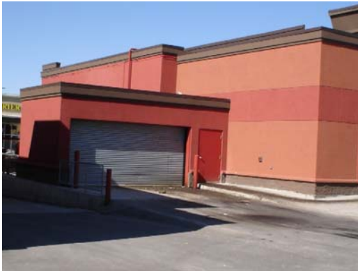
Figure 49a : Ce bâtiment possède des structures closes de stockage des ordures, de chargement et de service, qui sont accessibles depuis l'arrière.
