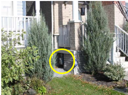
Figure 64a : Ce compteur est caché de la rue grâce à son intégration dans la conception de l'escalier.
