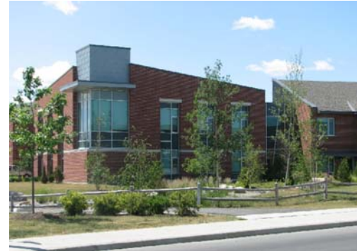
Figure 48a : La construction des bâtiments communautaires à proximité de la rue aide à créer une bordure urbaine invitante.
