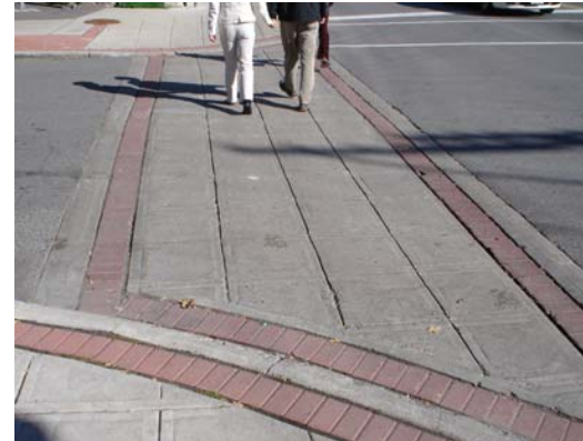
Figure 28a : Les passages pour piétons en pavés de pierre et de béton définissent clairement l'allée piétonnière.
