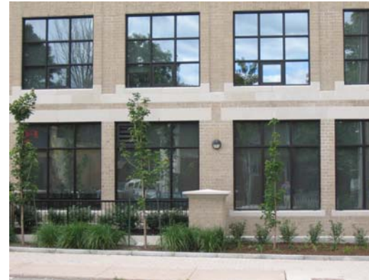
Figure 41a : Du verre teinté dissimule ce parc de stationnement en rez-de-chaussée tout en permettant une surveillance naturelle.
