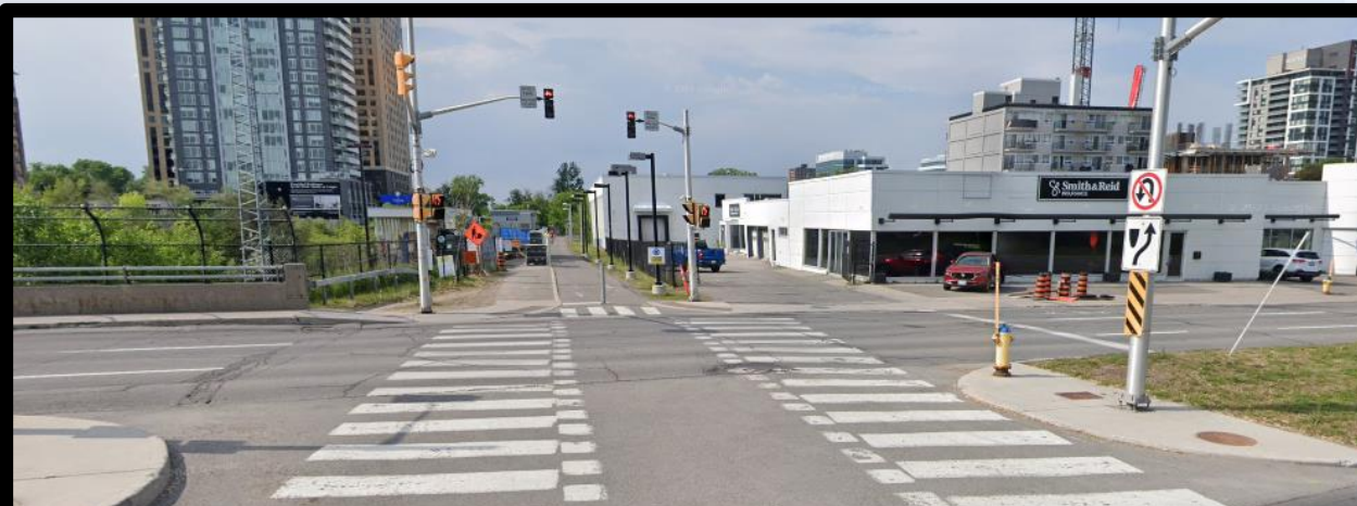
Carling mid-block crossing facing north/Passage pour piétons en section courante sur l'avenue Carling, en direction nord
