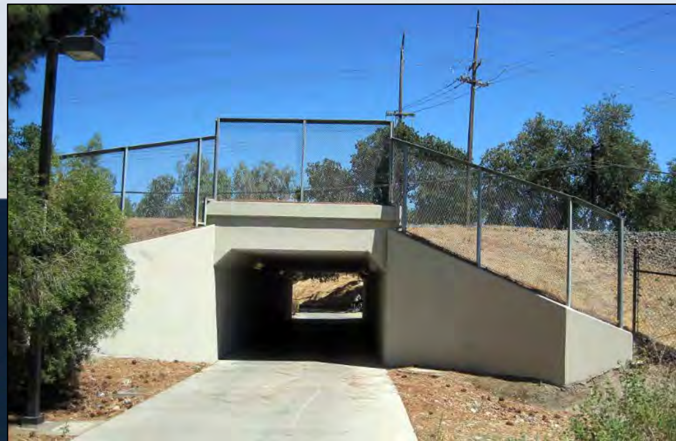
Alternative 1: Box Culvert Option 1 : Ponceau à dalot
