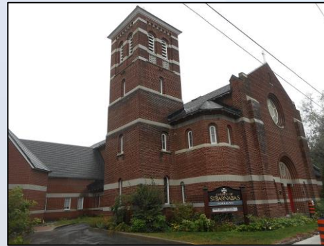
70 rue James St Church of St. Barnabas (west side) Église de St. Barnabas (côté ouest)
