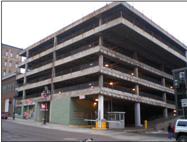
Figure 5 : Garage de stationnement à niveaux multiples
