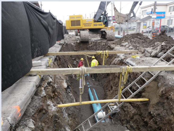
Travaux menés sur les conduites d'eau principales en faisant appel à des poutres pour étayer les câbles de services publics
