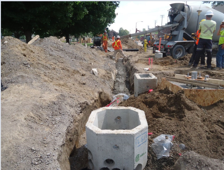
Installation des socles des lampadaires et des conduites
