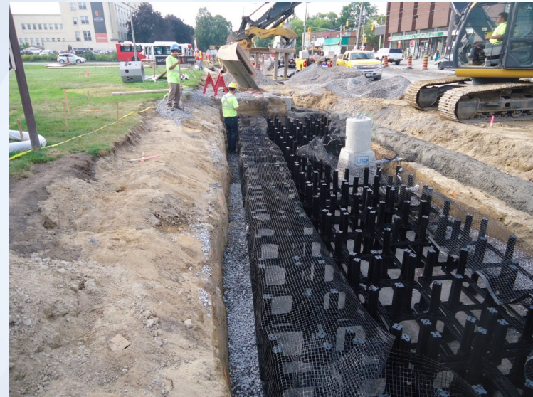
Installation de cellules de sol pour les arbres
