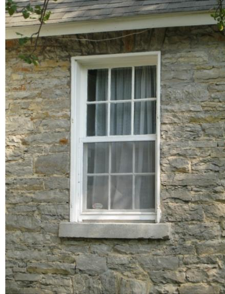
Figure 11 : Les fenêtres historiques étaient généralement à guillotine, à carreaux multiples et faites de bois.
