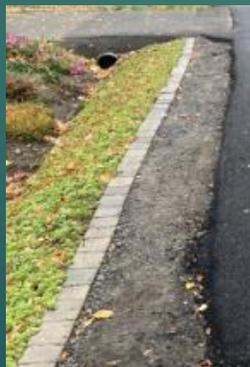
► Un fossé est un canal creusé dans le sol et qui achemine l'eau pendant les tempêtes et la fonte printanière, de façon à prévenir l'endommagement des infrastructures publiques et privées. Les fossés et les conduites d'eaux pluviales font partie de l'ensemble du réseau des infrastructures des eaux de surface.
