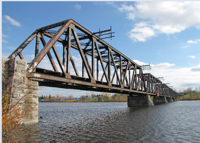
Pont Sud, vue vers le sud
