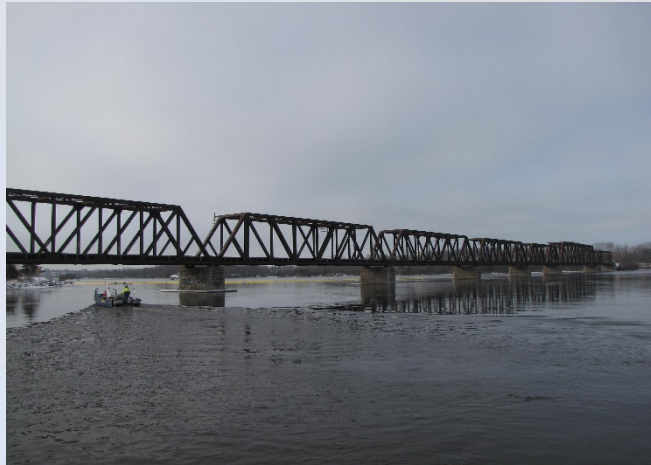
Pont Nord, vue vers le nord
