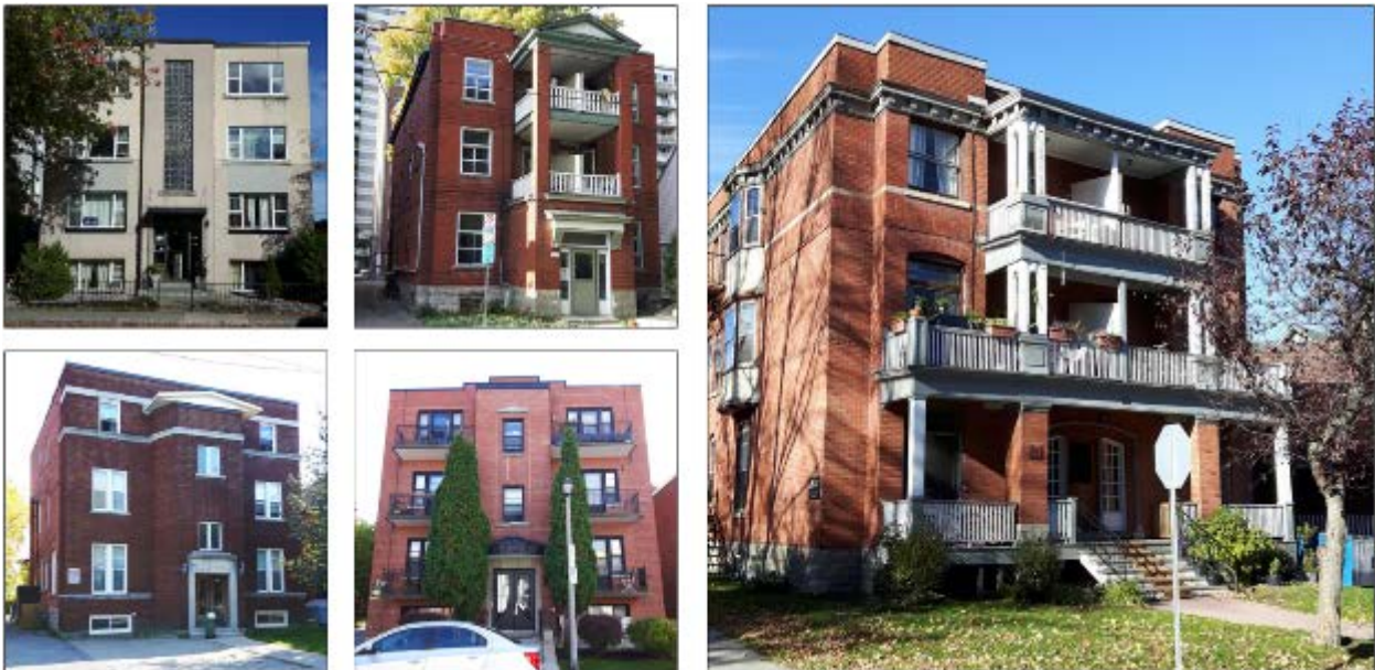
Figure 2 : Les immeubles d'appartements plus anciens, sans ascenseur, constituent une caractéristique familière des quartiers urbains comme Vanier, le centre-ville, la Côte-de-Sable, la Basse-Ville et le Golden Triangle. Or, depuis des dizaines d'années, il est difficile de construire à Ottawa ce type de logements à cause du zonage et d'autres règles.
