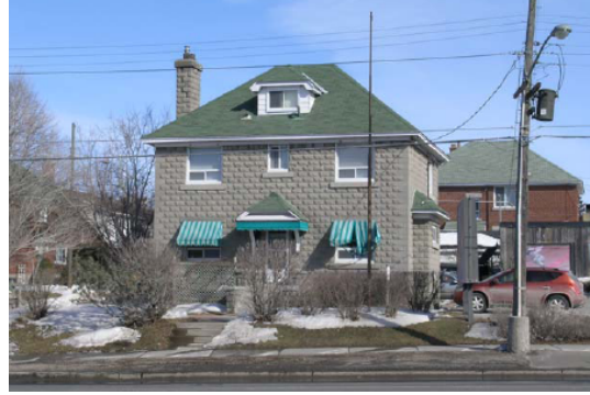
La propriété du 1663, rue Bank est connue pour sa valeur patrimoniale mais n'est pas désignée officiellement (Google Maps, 2011)
