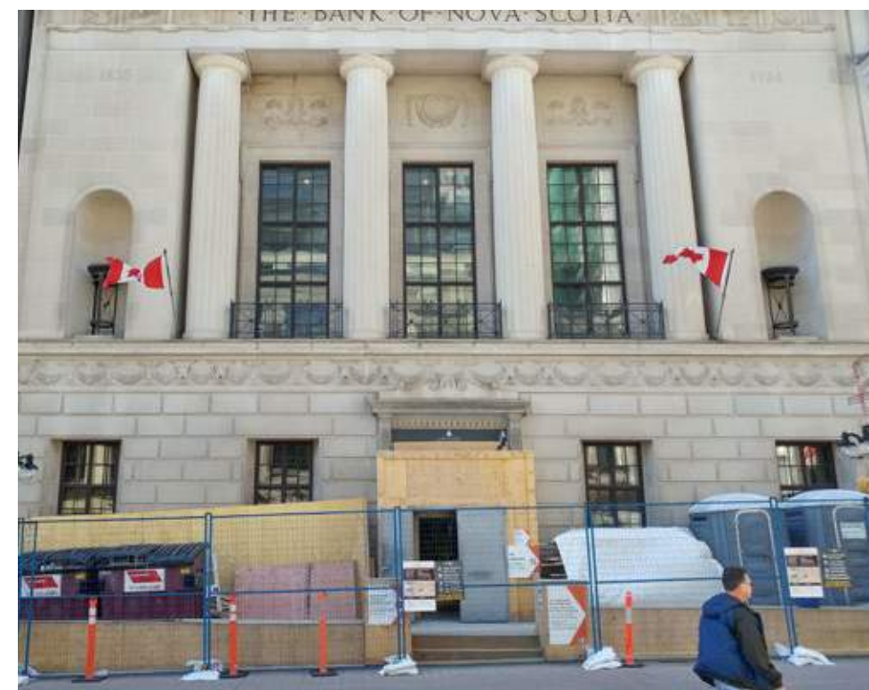
Fig. 25 Travaux au bâtiment de la Banque Nova Scotia Source: Vlan + civiliti
