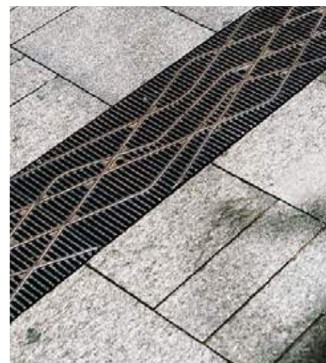
Fig. 140 Grillage décoratif d'une tranchée technique Source: www.landezine.com/index.php/2013/10/pitt-street-mall-by-tony-carro-architecture/
