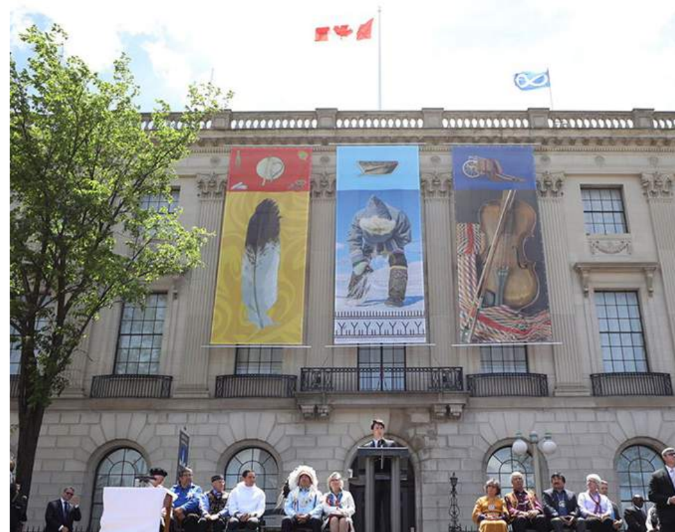
Fig. 41 Le 100 rue Wellington, futur centre des peuples autochtones Source : tpsgc-pwgsc.gc.ca
