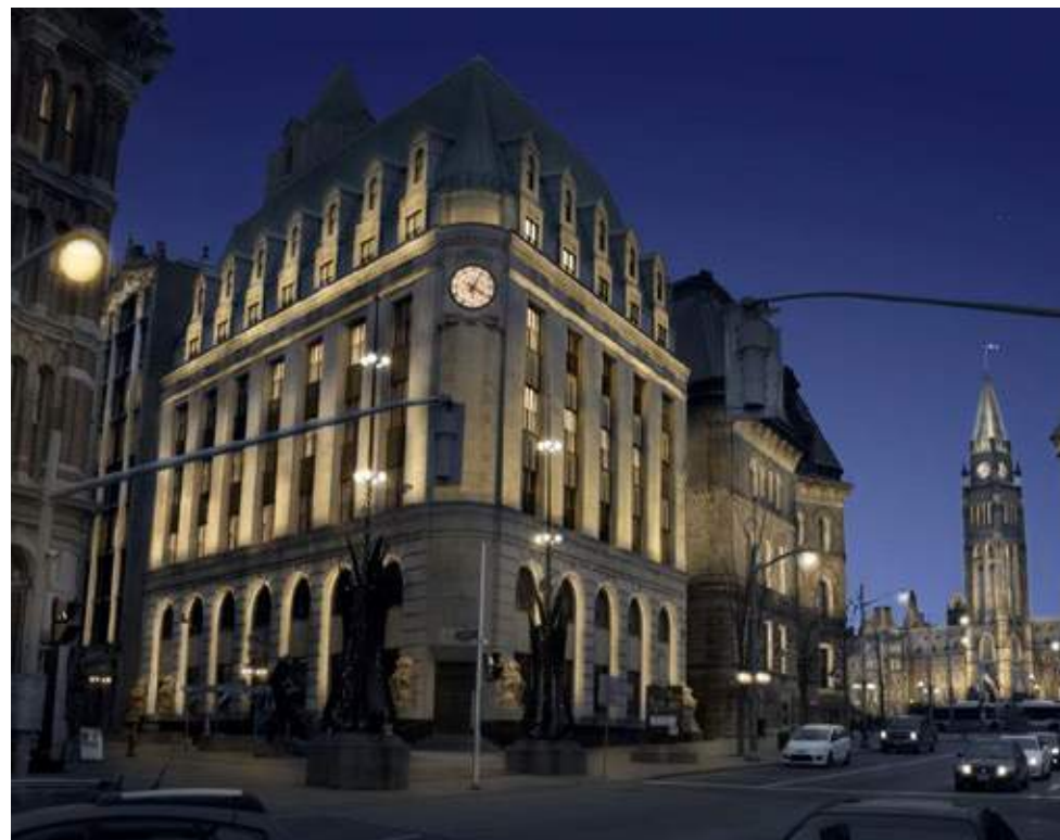
Fig. 62 Vue des rues Elgin et Sparks depuis le côté est de la rue Elgin Source : Parliamentary Precinct Exterior Lighting Master Plan, 2015
