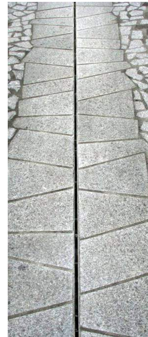
Fig. 142 Drain d'écoulement dans le pavé Source: www.landezine.com/st-flour-pavement-by-insitu-landscape-architecture-01.jpg
