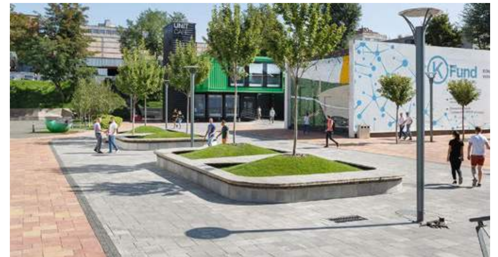
Fig. 111 Bacs de plantation en béton avec dessus en bois Source: www.toronto.ca/services-payments/streets-parking-transportation/walking-in-toronto
