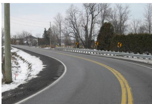
Figure 11 – Glissière de sécurité dans une courbe
