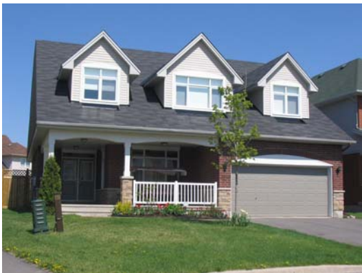
Figure 44b : La limitation de la largeur des garages et des entrées privées permet d'équilibrer les proportions de la façade avant et augmente l'espace disponible pour un aménagement paysager et le stockage de la neige en hiver.
