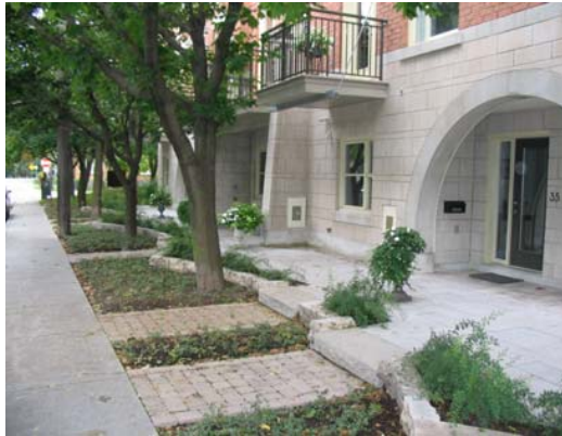
Figure 40a : Les portes des appartements en rez-de-chaussée permettent d'intégrer une utilisation active dans le paysage de rue au niveau des piétons.
