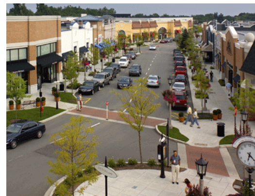
Figure 28b : Les trottoirs en saillie et les rayons d'angle réduisent la vitesse de virage des véhicules et limitent la distance de traversée des piétons.
