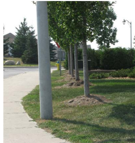
Figure 65a : La séparation des tranchées de services souterrains et des racines des arbres plantés respecte les exigences de chaque utilisation et permet de limiter les conflits.
