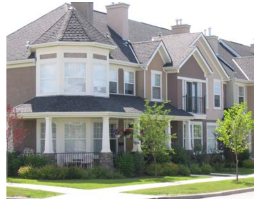
Figure 37a : Le traitement des portes et des fenêtres qui enveloppent cette habitation offre un intérêt visuel sur les deux voies publiques.
