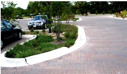
Figure 51b : Les îlots de plantation à bordures arasées permettent de récupérer l'eau de pluie des aires pavées.
