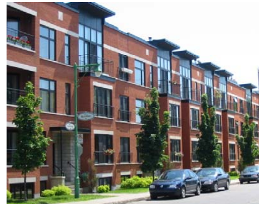
Figure 37b : Les portes et les fenêtres aident à créer une échelle humaine et un environnement piétonnier confortable.
