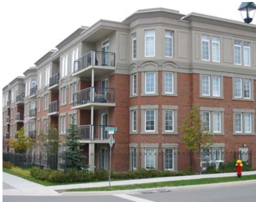
Figure 38a : Tous les types de bâtiments d'angle doivent présenter une façade détaillée donnant sur chaque voie publique.
