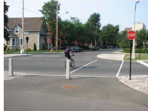
Figure 32b : Ce sentier polyvalent traverse la route en dirigeant les cyclistes vers la route et les piétons vers le passage pour piétons et le trottoir.
