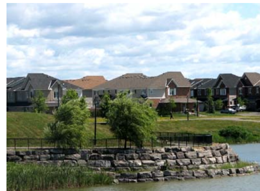
Figure 55b : Les clôtures entourant ce bassin de gestion des eaux pluviales correspondent au style général de cette installation et contribuent à la sécurité des lieux.
