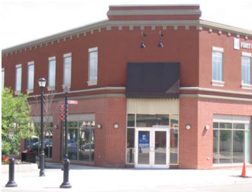
Figure 47b : La façade de ce bâtiment commercial est orientée vers la rue, avec de grandes fenêtres transparentes au niveau de la rue et une entrée orientée vers les deux voies publiques.
