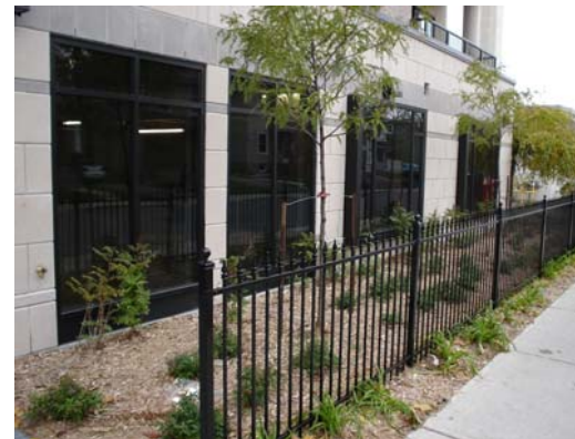
Figure 41b : L'aménagement paysager cache davantage ce garage de stationnement en rez-de-chaussée.
