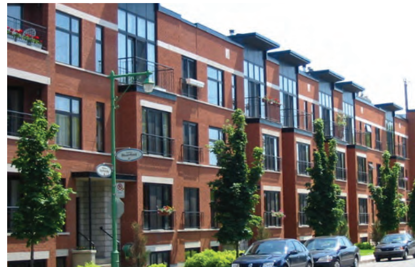
Figure 54 : Les fenêtres et les portes permettent de créer une ambiance d'échelle humaine et un environnement piétonnier confortable.
